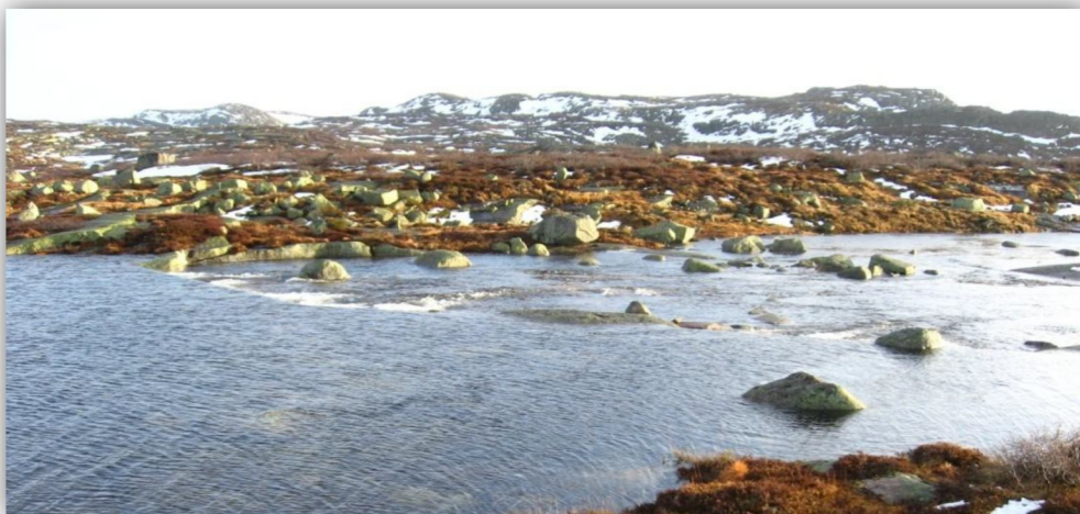
Figur 10.2; Sperredam Eivindsvann oppstrøms med overløp
