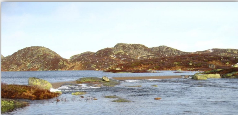
Figur 10.3; Sperredam Eivindvatn nedstrøms med overløp
