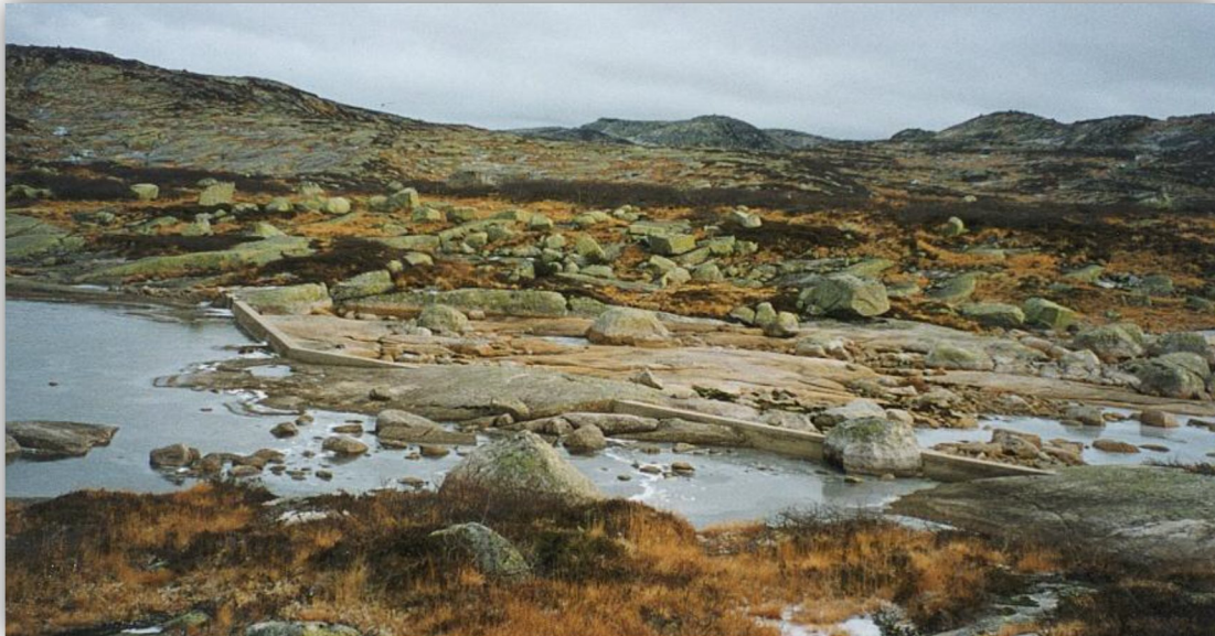
Figur 10.1; Sperredam Eivindsvann oppstrøms uten overløp
