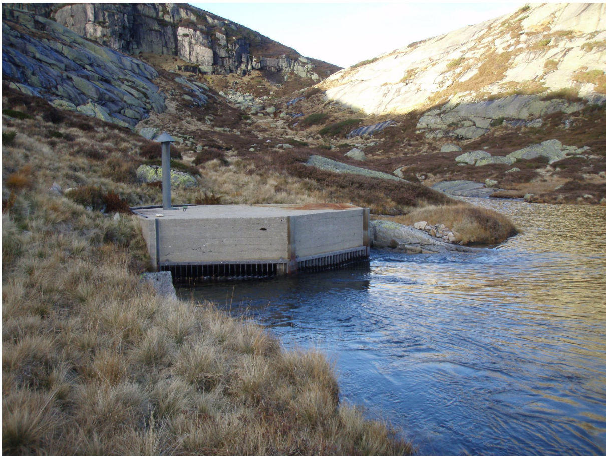
Tunnelinntak. Vannnivå er her 55cm over bunnterskel, ca 10 cm under utløpsterskel mot Krokevatn.
