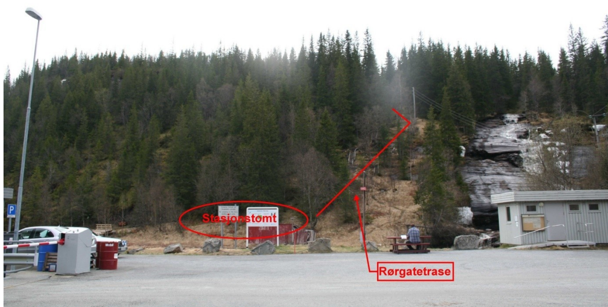
FIGUR 36: STASJONSOMRÅDET SETT FRA FERJEKAIEN.
