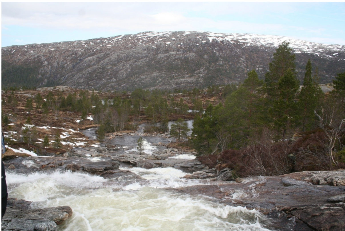
FIGUR 30: VANNSTRENGEN SETT FRA INNTAKSOMRÅDET.
