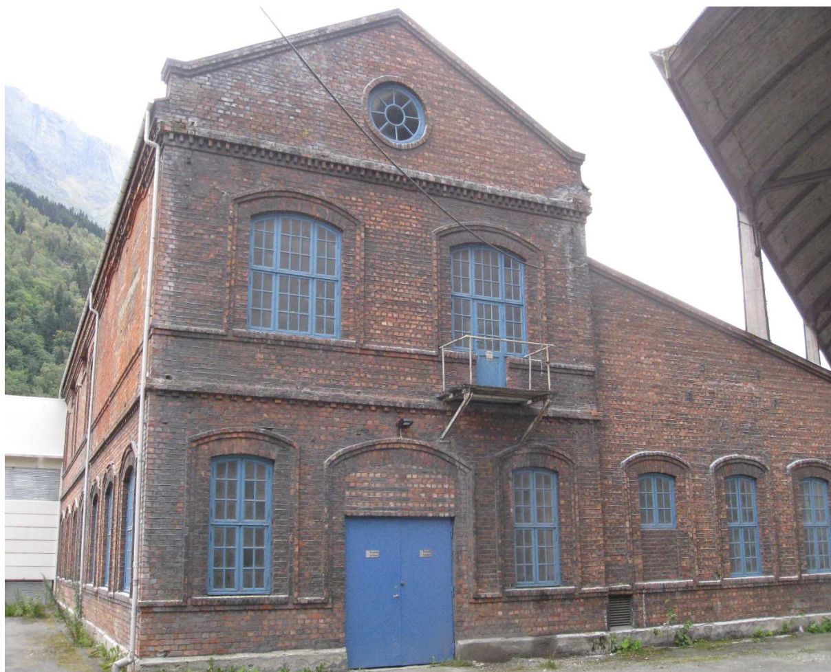
Bilde: Bygg til varmesentral
