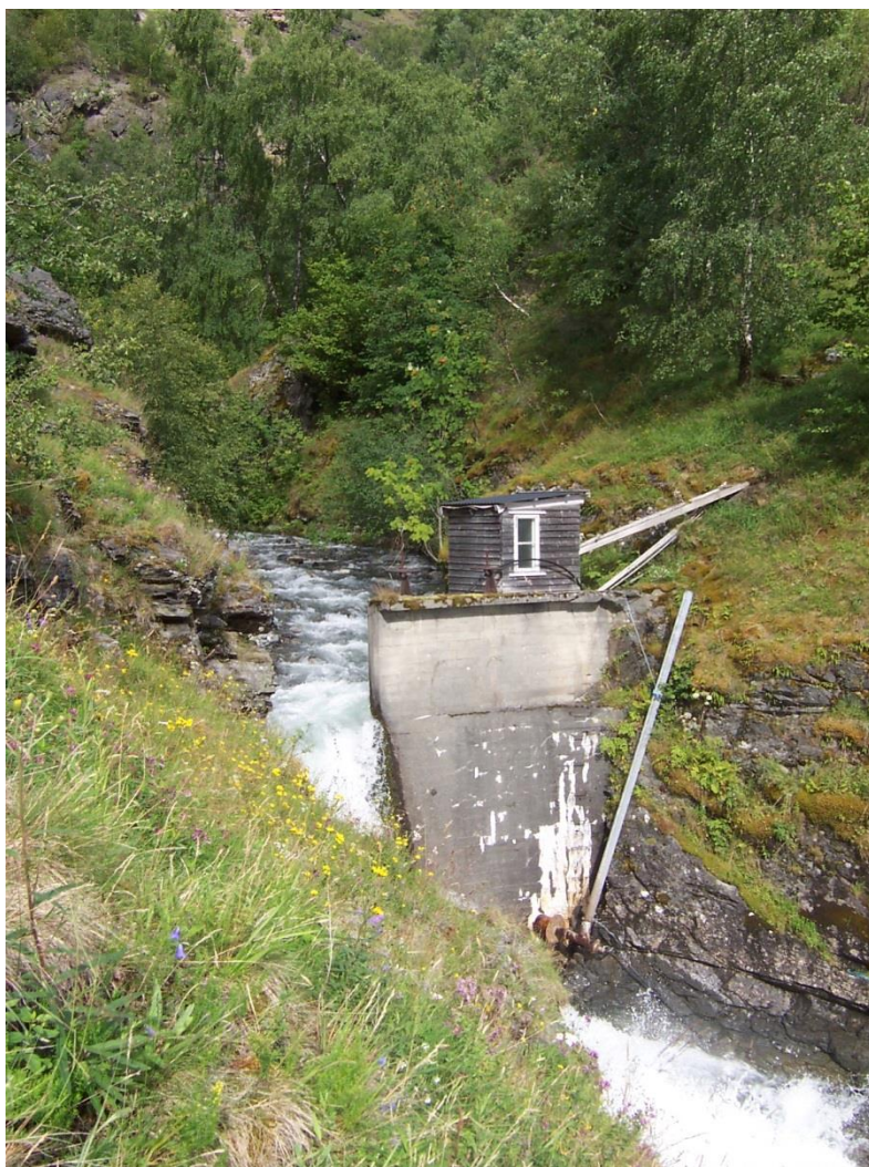
Figur 22. Nede ved fjorden finst restar etter inntaksdammen til eit gammalt kraftverk
