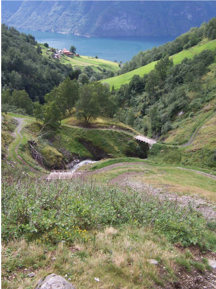
Inntakssted inntak alternativ 2.2. Kraftstasjon 2.1 til høyre i bildet.
