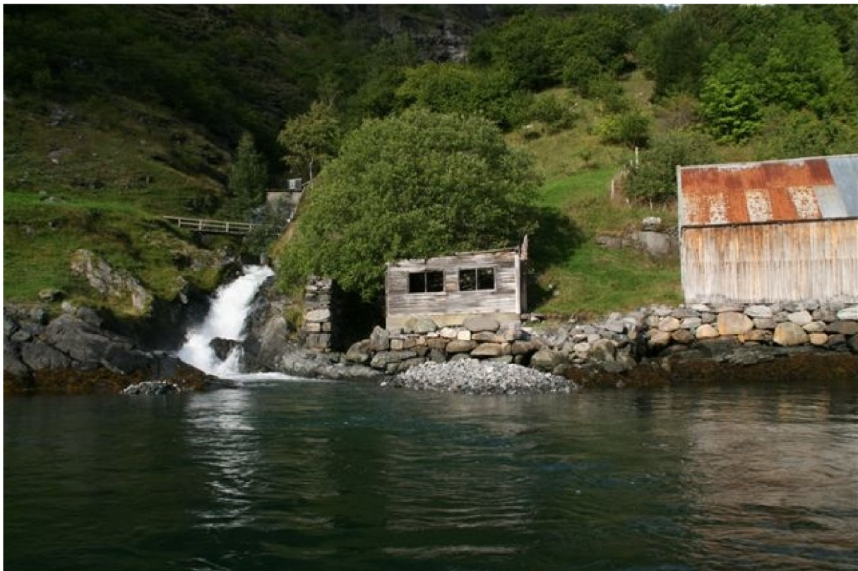
Bilde 3. Utløp ved fjorden. Middels vannføring
