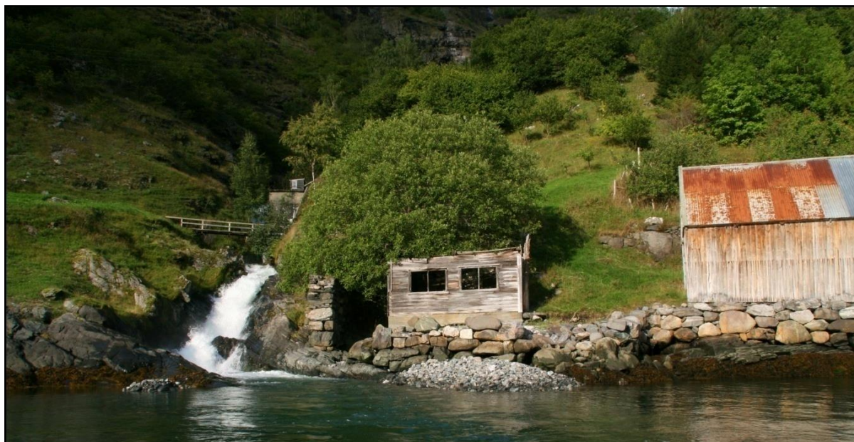
Figur 12. Nede ved fjorden finst restar etter inntaksdammen til eit gammalt kraftverk Storelvi renn ut ved Ståi/Ståflaten nede ved fjorden. Kraftstasjonen er planlagt bygd på tuftene frå den gamle kraftstasjonen (kote 2). Ein ny kraftstasjon vil med god landskapstilpassing kunne påverke området i positiv retning. Ovanfor brua ser vi restane etter ein eldre inntaksdam med kraftverk.
