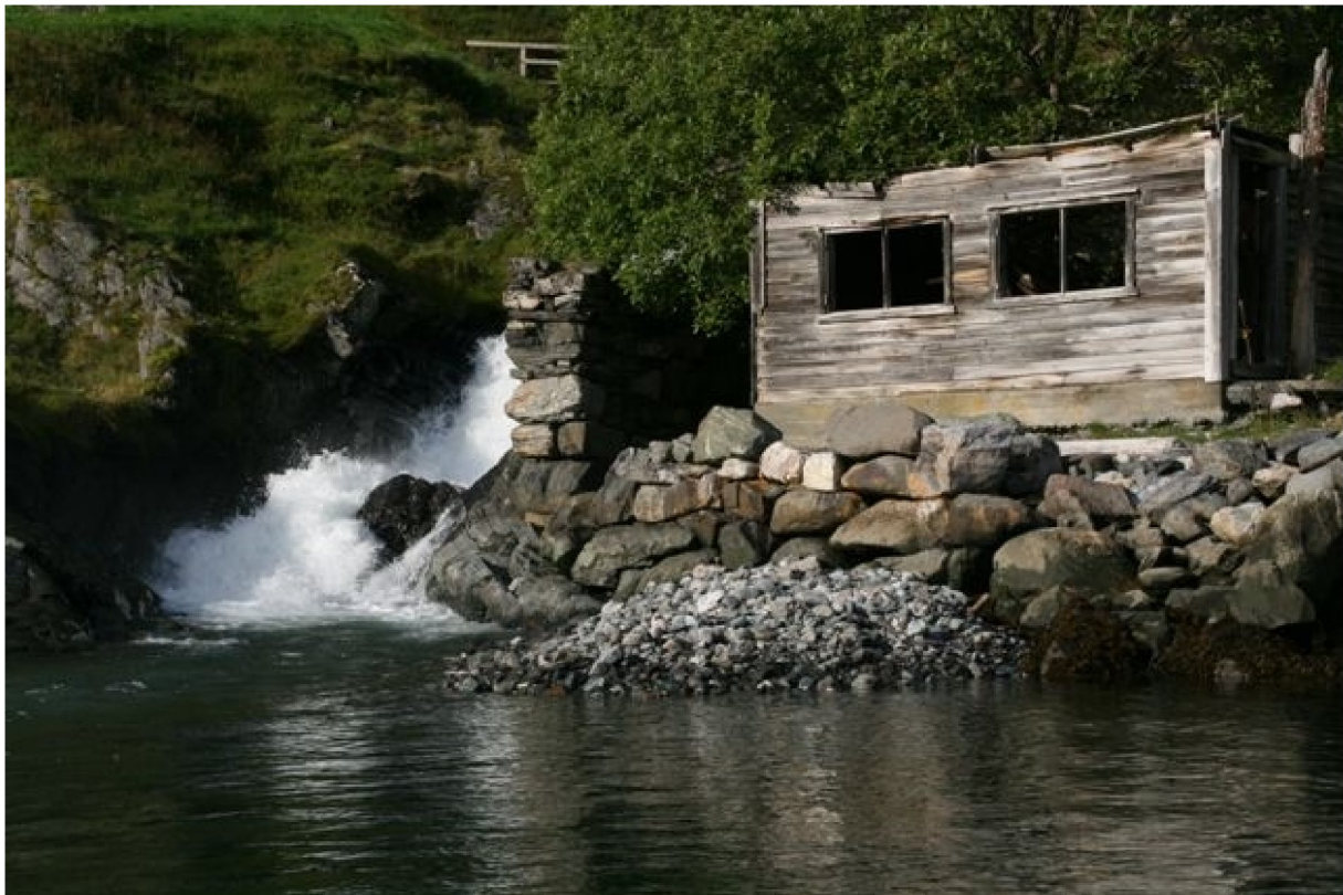
Bilde 2. Utløp ved fjorden. Middels vannføring
