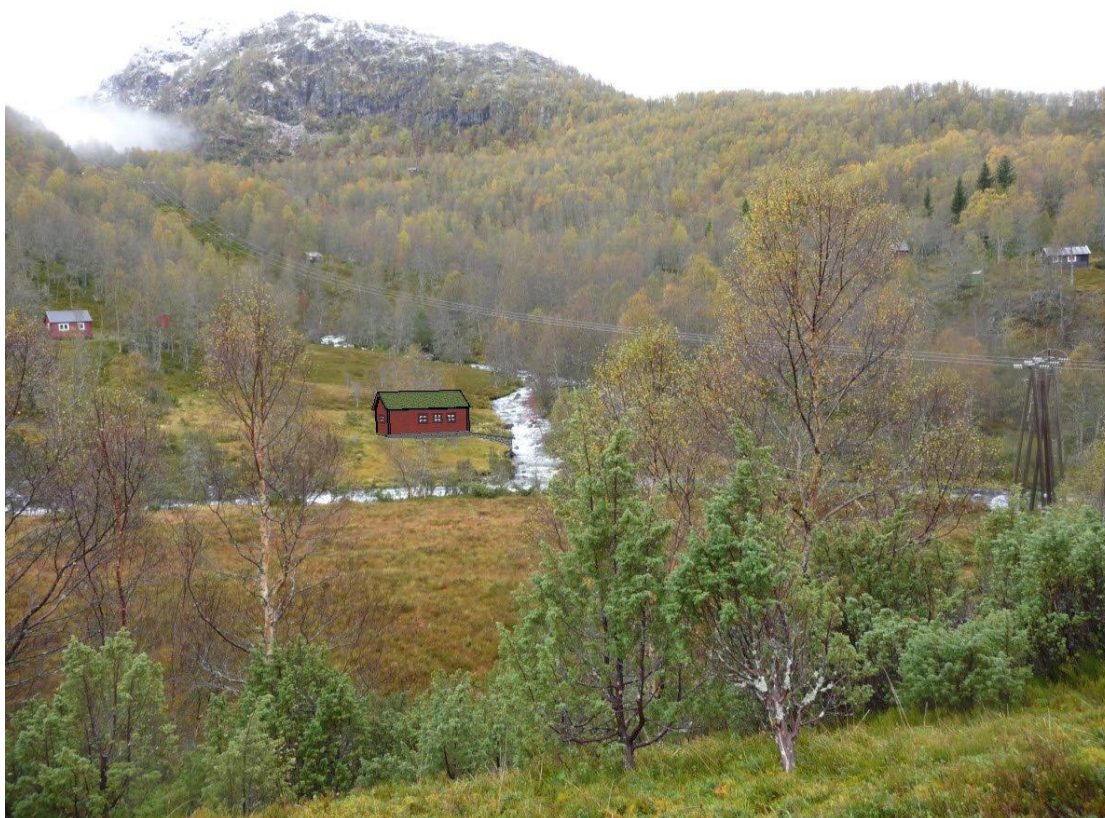
Vedlegg 2: Bilde 2 Planlagt stasjonsplassering. Bildet tatt i retning sør.
