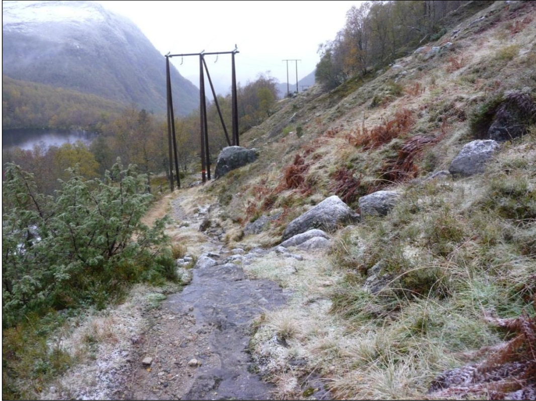
Vedlegg 2: Bilde 1 Rørtraseen sett nedover ca 300 m fra inntaket. Rørtaseen vil krysse linja som ved bildestandplassen vil gå ca midt i bildet.
