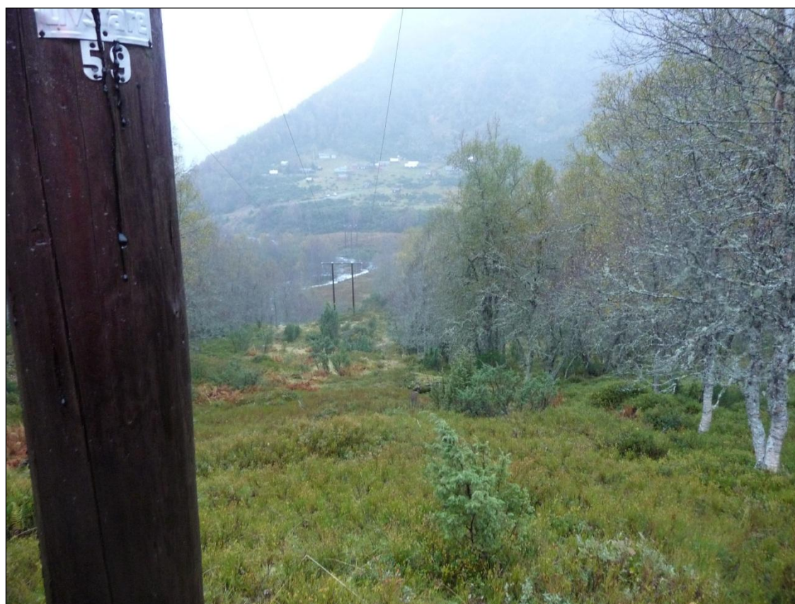
Vedlegg 2: Bilde 3 Rørtraseen sett ca midtveis ned fra inntaket. Bildet er tatt i retning Breistølen.
