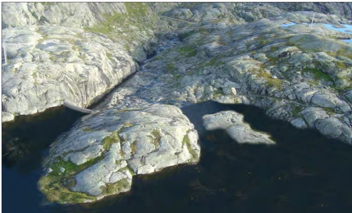
Figur 3.1 Fotomontasje av Dam Austdølvatnet sett oppstrøms. Overløpstterskelen sees midt i bildet.
