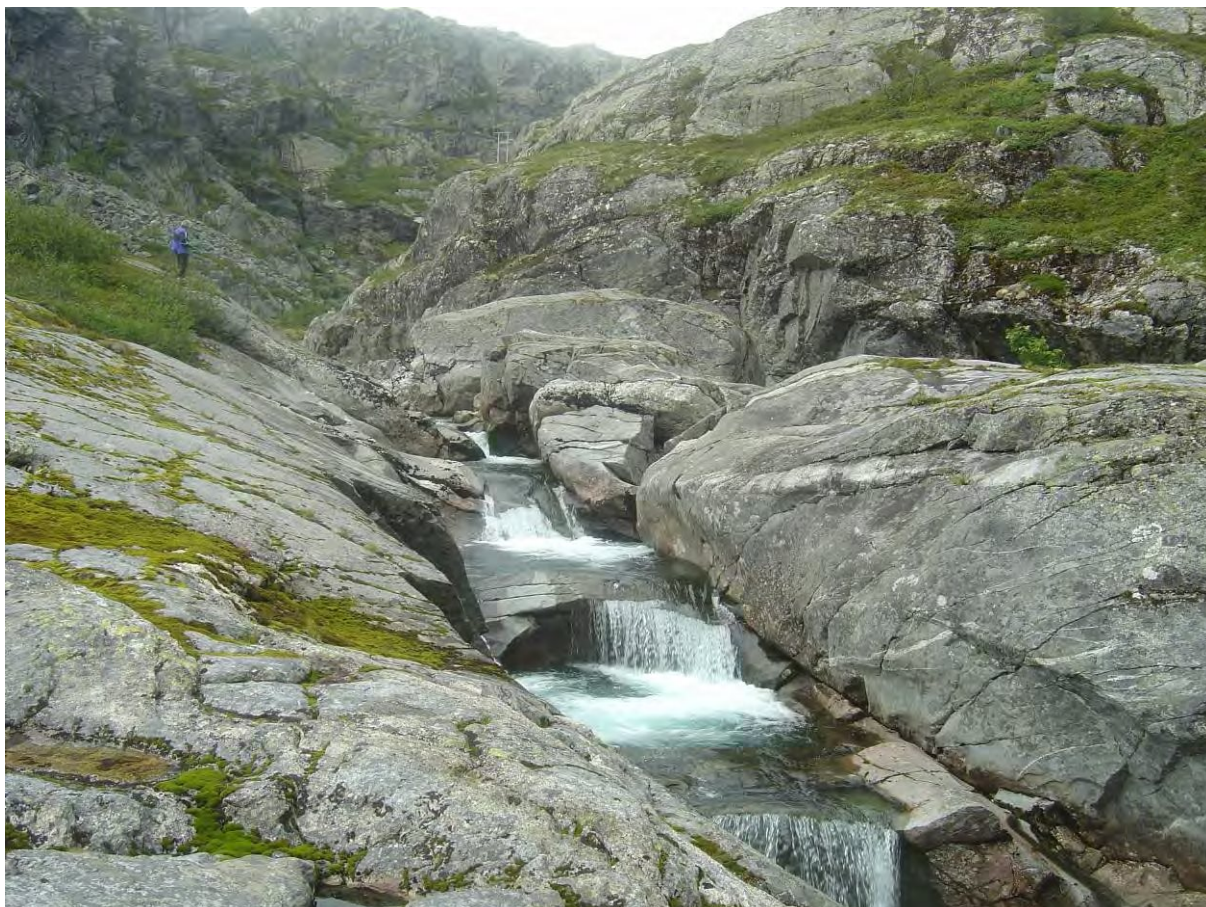
Inntaksdammen for Austdøla kraftverk. Sett mot Viermyr rundt hjørnet
