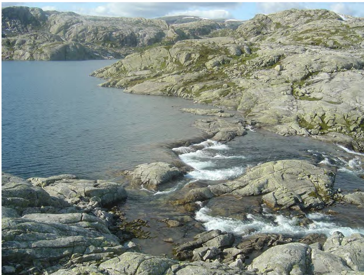
Utløp Floskefonnvatn. Ny terskeldam med inntakskonstruksjon nærmest
