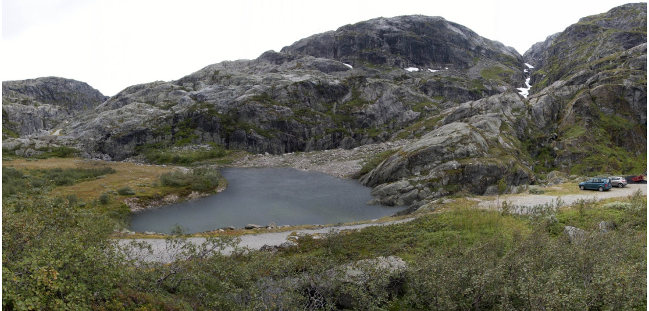
Figur 4-4. Fotomontasje av inntaksbasseng til Austdøla kraftverk.
