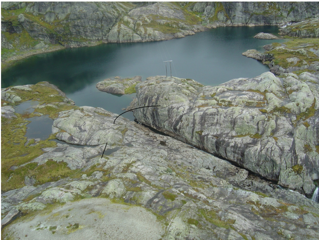
Dam Austdølvatn med plassering av overløpsterskel (rett linje). Utløp fra gammel tunnel synlig i høyre billedkant
