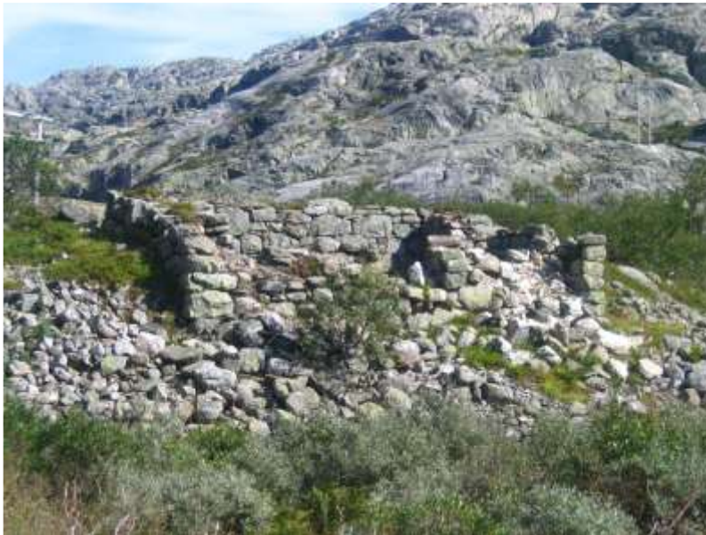
Figur 12. Tidligere lagerbygning på Viermyr.
