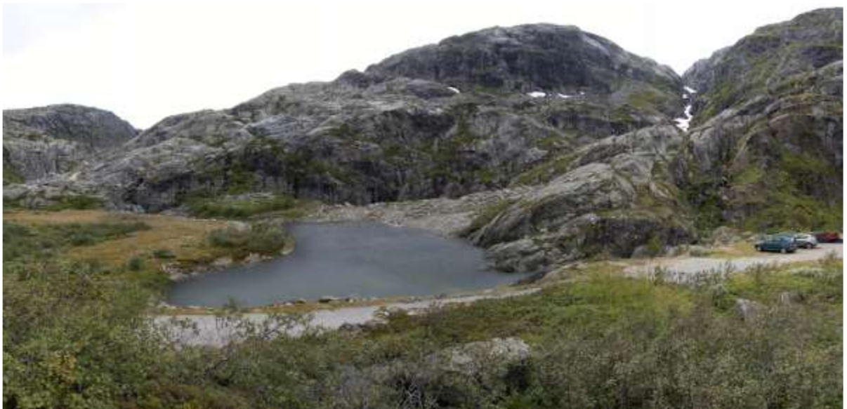
Figur 32. Ny inntaksdam for Austdøla kraftverk på Viermyr.
