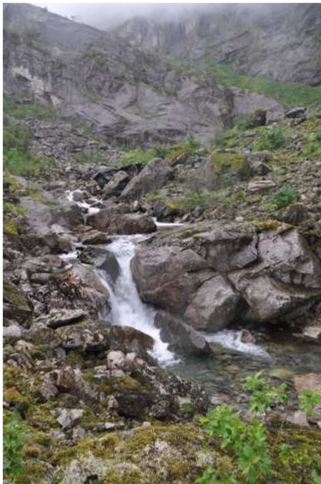
Figur 44. Nedre del av elvestrekningen til Austdøla Kraftverk etter samløp med første sidevassdrag sett fra anleggsveien med vannføring 1,14 m 3 /s (dato 15.08.2011).
