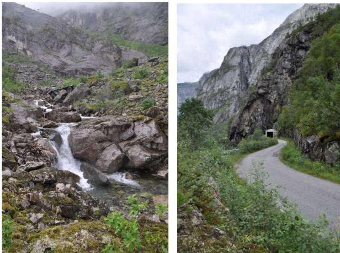
Figur 15. Austdøla og anleggsveien med tunnel.
