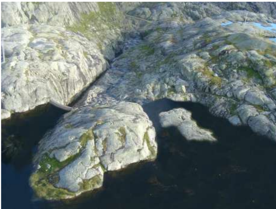
Figur 24. Betongdam og overløpterskel ved utløp Nedre Austdølvatnet etter utbygging ved HRV 912.
