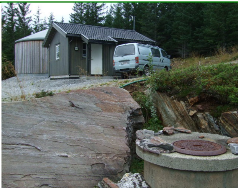
Det kommunale vannverket i Langsetelva. Foto: Morten W. Melby.
