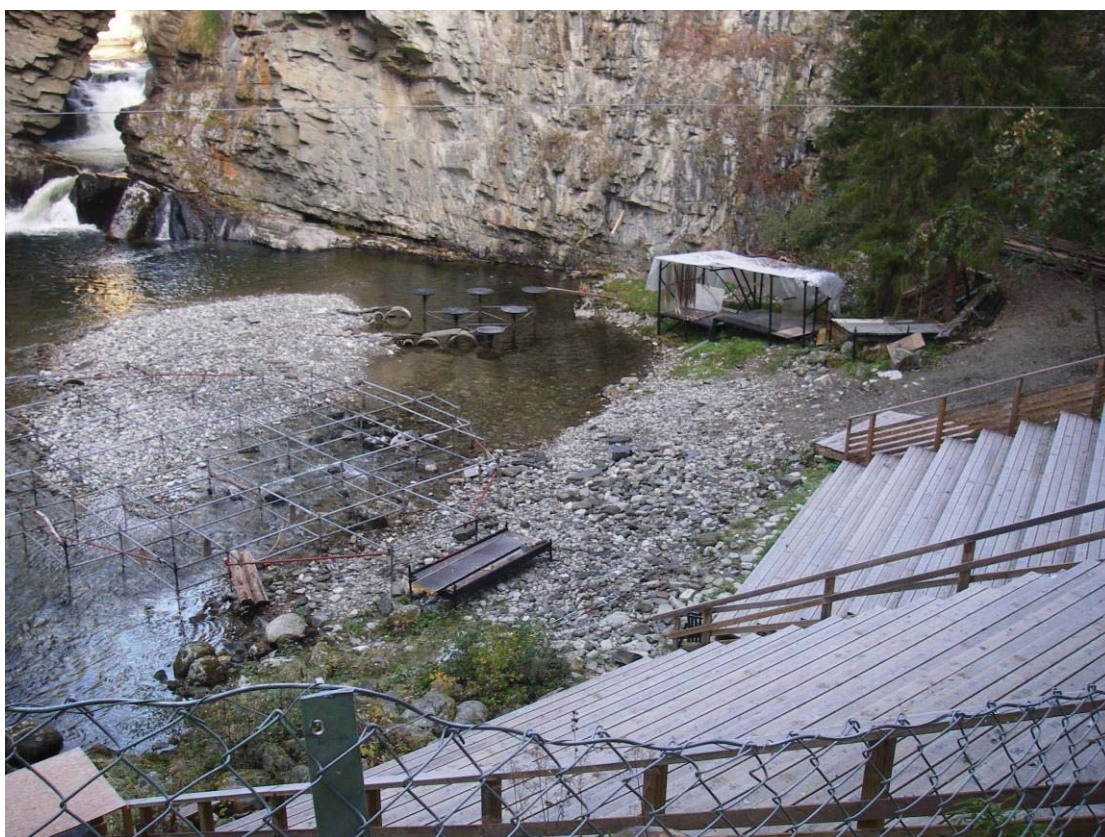
Bildet viser den delvis demonterte utescenen i Bergveinshølen
