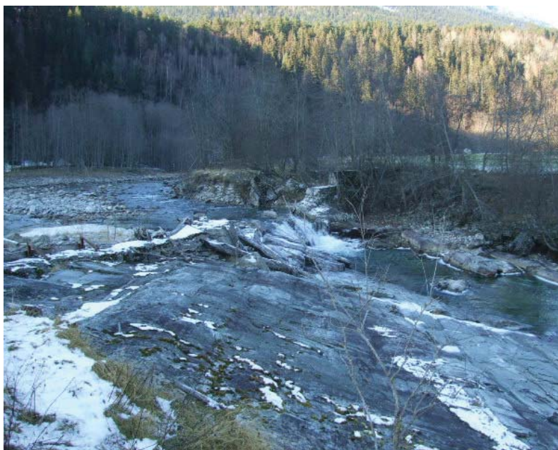
Rester etter inntaksdammen fra tidligere regulering. Foto: Morten W. Melby.
