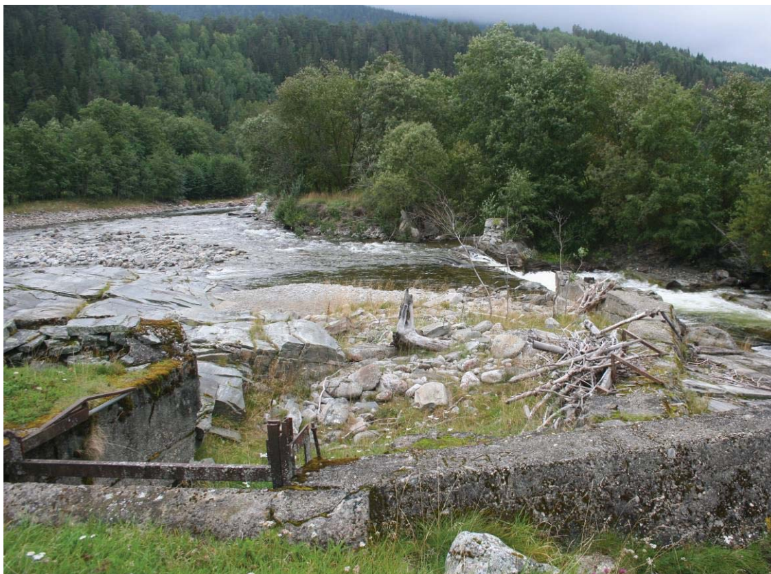
Bildet viser restene av inntaket til det gamle kraftverket
