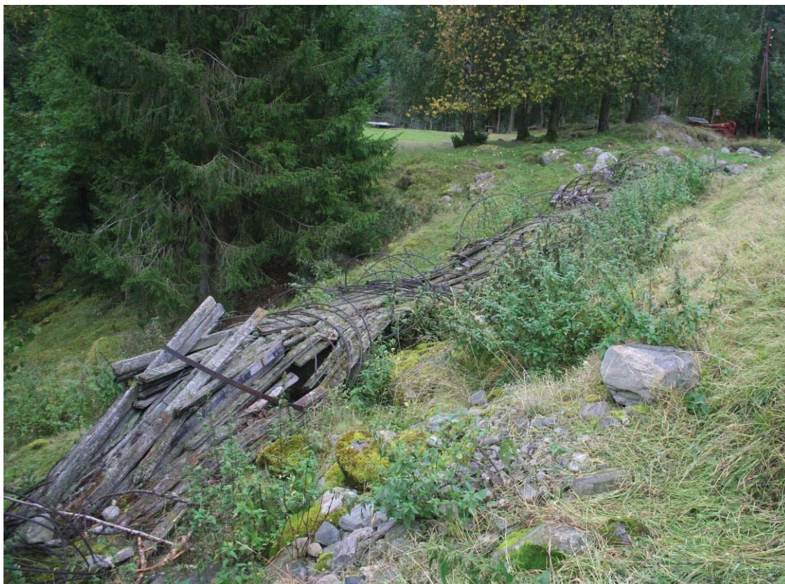
Fra enden av betongkulverten gikk den gamle vannveien over i trerør som en fremdeles kan se restene av i terrenget
