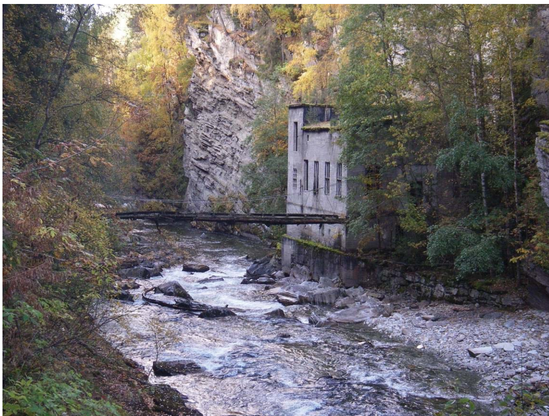
Den gamle kraftstasjonen i Frya sett fra Bergveinshølen
