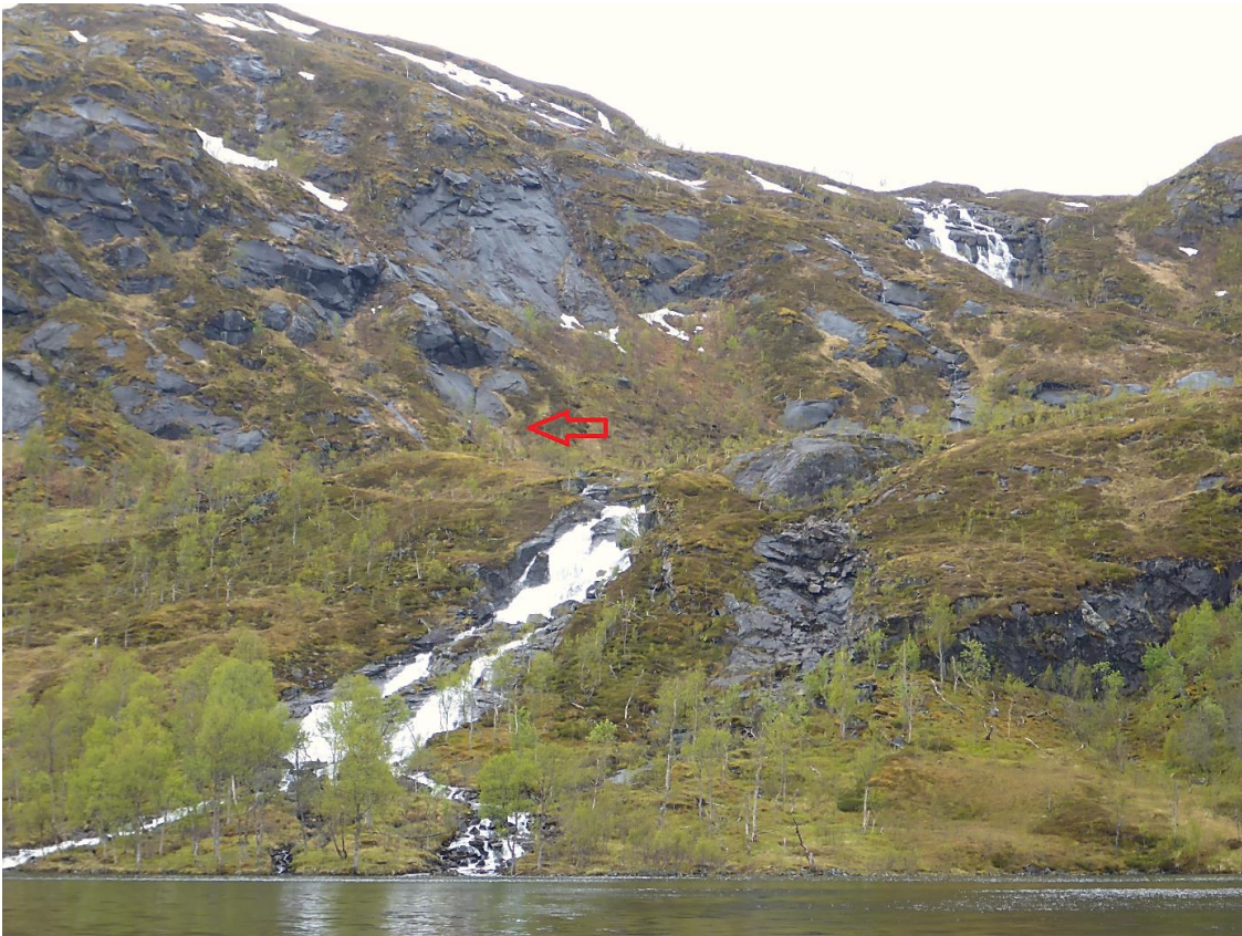
Bilde 1 Sørrelva sett fra båt fra Finnsætervatn. Kraftstasjons- og rørgateplassering til venstre for elva. Tunnelpåhogg planlagt ved pil.
