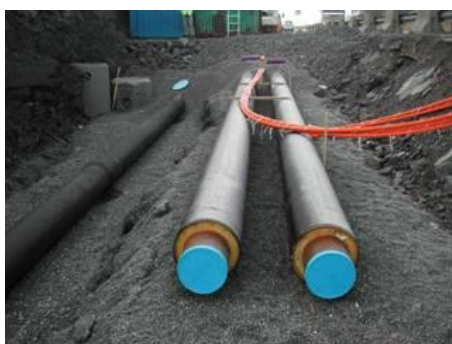
Figur 12. Døme på fjernvarmerøyr
