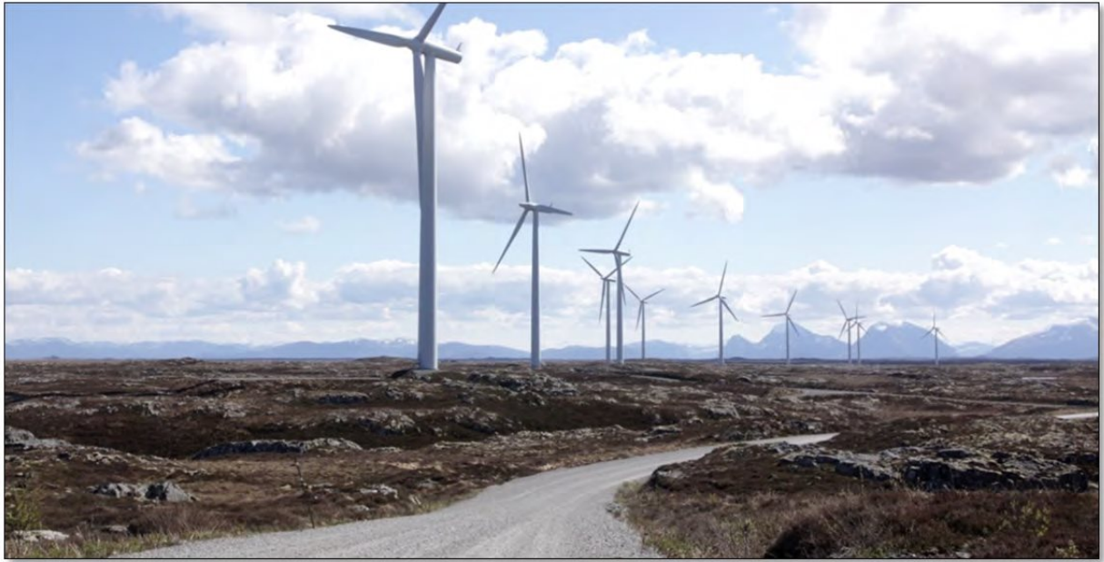
Figur 4. Smøla vindkraftverk med internveger og vindturbiner. Vegene som bygges i forbindelse med vindkraftverk har grusdekke og normalt en bredde på ca. 5 m pluss evt fyllinger/skjæringer. Adkomst- og internvegene på Buheii vindkraftverk vil også kunne brukes av grunneierne i forbindelse med skogsdrift eller tilsyn med beitedyr.
