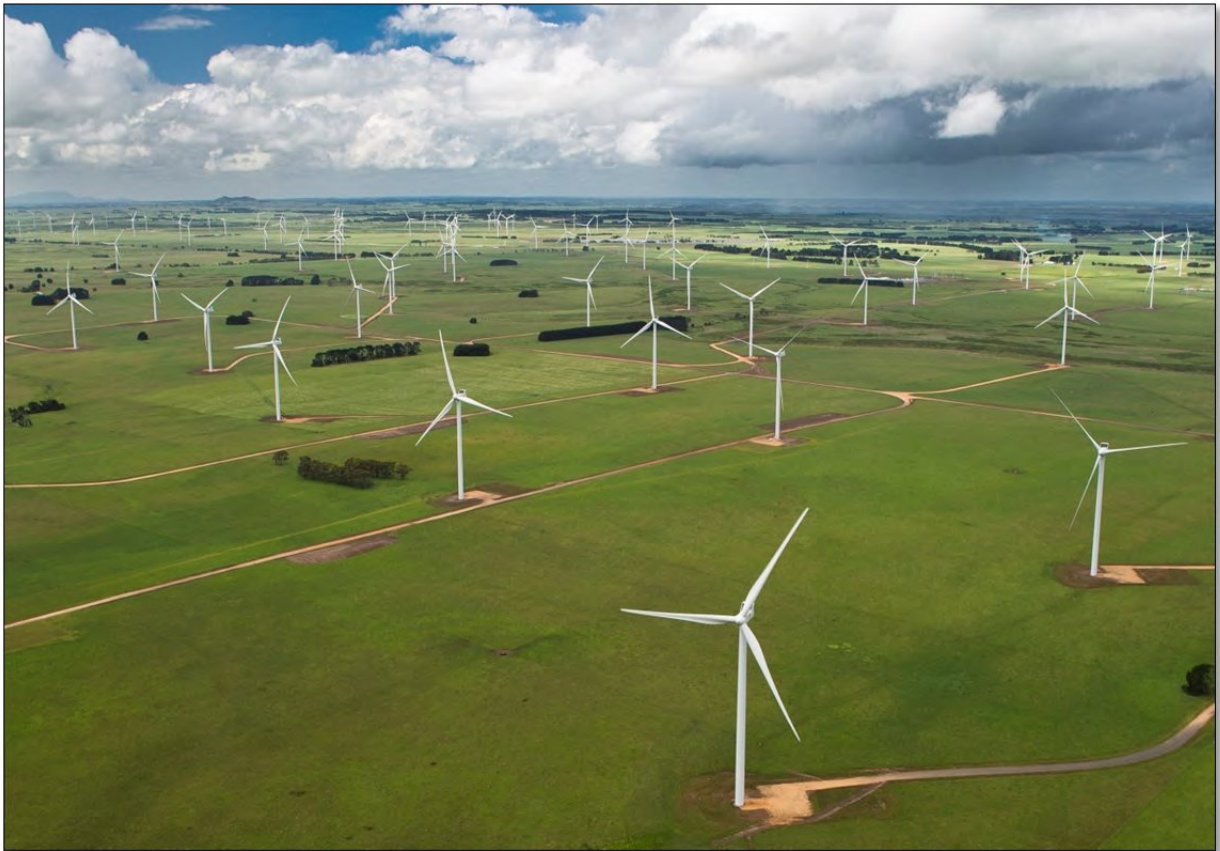
Figur 2. Vestas V112 turbiner i et australsk landskap. Et internt nettverk av veger og jordkabler legges mellom turbinene og trafo/driftsbygning sentralt i planområdet. Kilde: Vestas.
