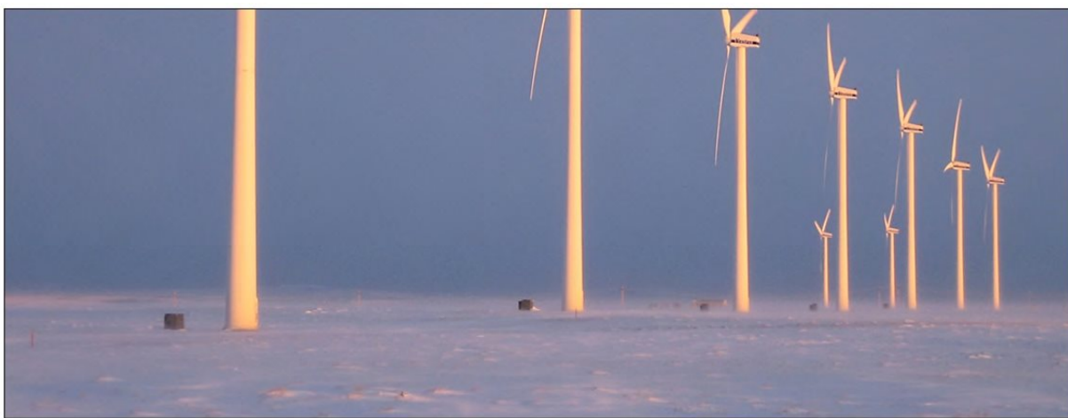
Figur 54. Iskast fra rotorbladene utgjør en potensiell risiko for folk som ferdes nærmere enn ca. 200 m fra turbinene.
