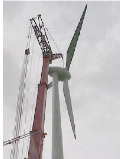
Figur 10: Eksempel på vindturbinfundament og montering av turbin ved hjelp av spesialkran
