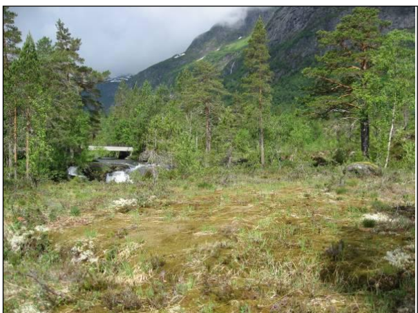
Bilde 22. Rørgaten føres nedover øst for elven
