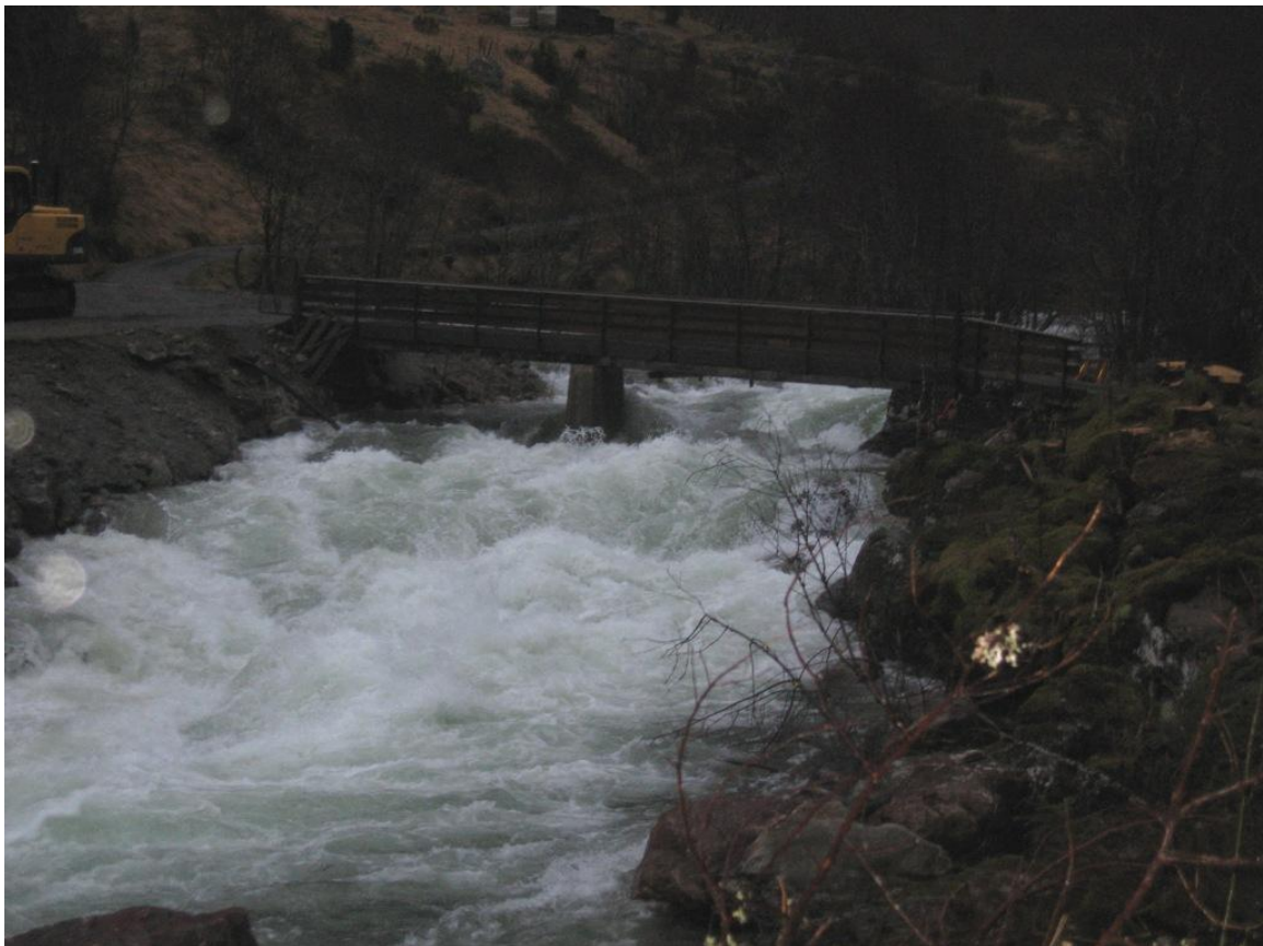
Vedlegg 2 Bilde 8. Dato 12.01.2009: Vannføring: 12,57 \text{ m}^3/\text{s} nedenfor stasjon alt. 1
