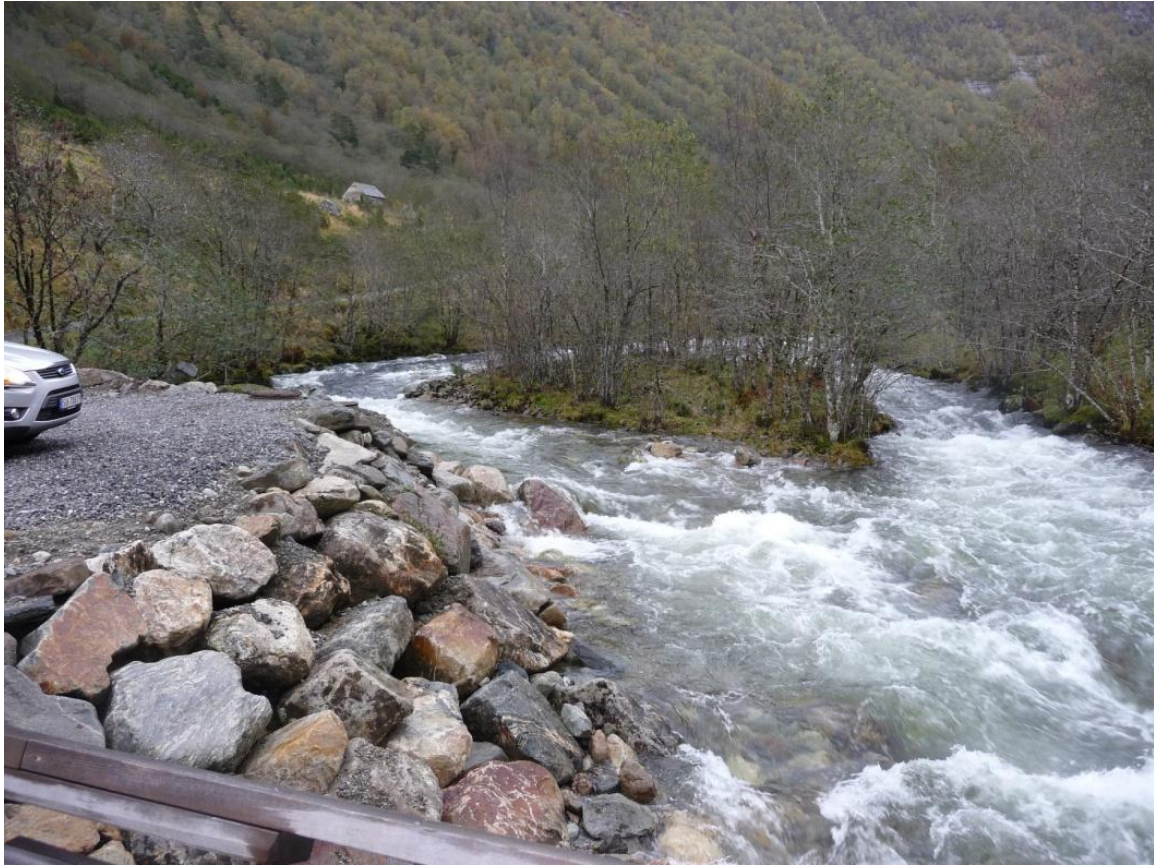
Vedlegg 2 Bilde 7. Dato 07.10.2009: Vannføring: 8,39 \text{ m}^3/\text{s} nedenfor stasjon alt. 1
