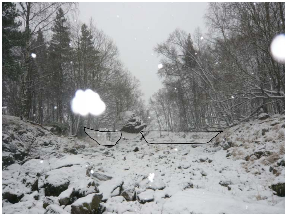
Figur 6.2: Gravitasjonsdam nr.2 i det naturlige utløpet av Digraneselvi.
