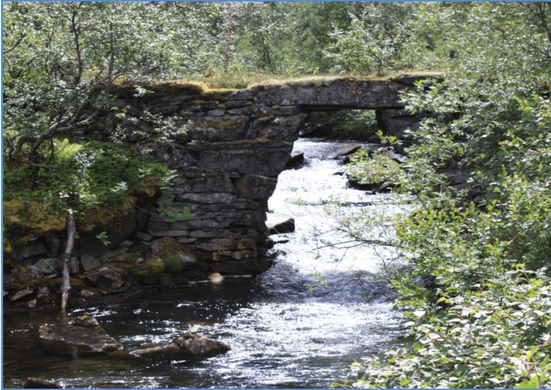
Figur 3.10.4 Bilde av steinbrua, del av gammel ferdselsveg.
