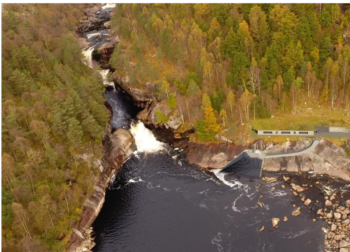
Figur 19 Oversiktsbilde kraftstasjon og Rafossen
