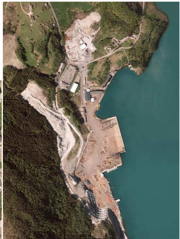
Figur 5: AF Decom sitt kaianlegg
