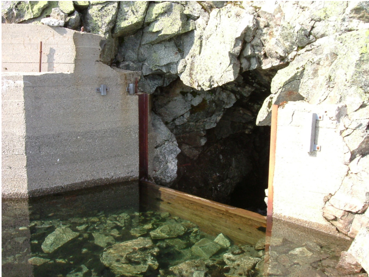
Figur 2 Inntaket i Harkavatnet
