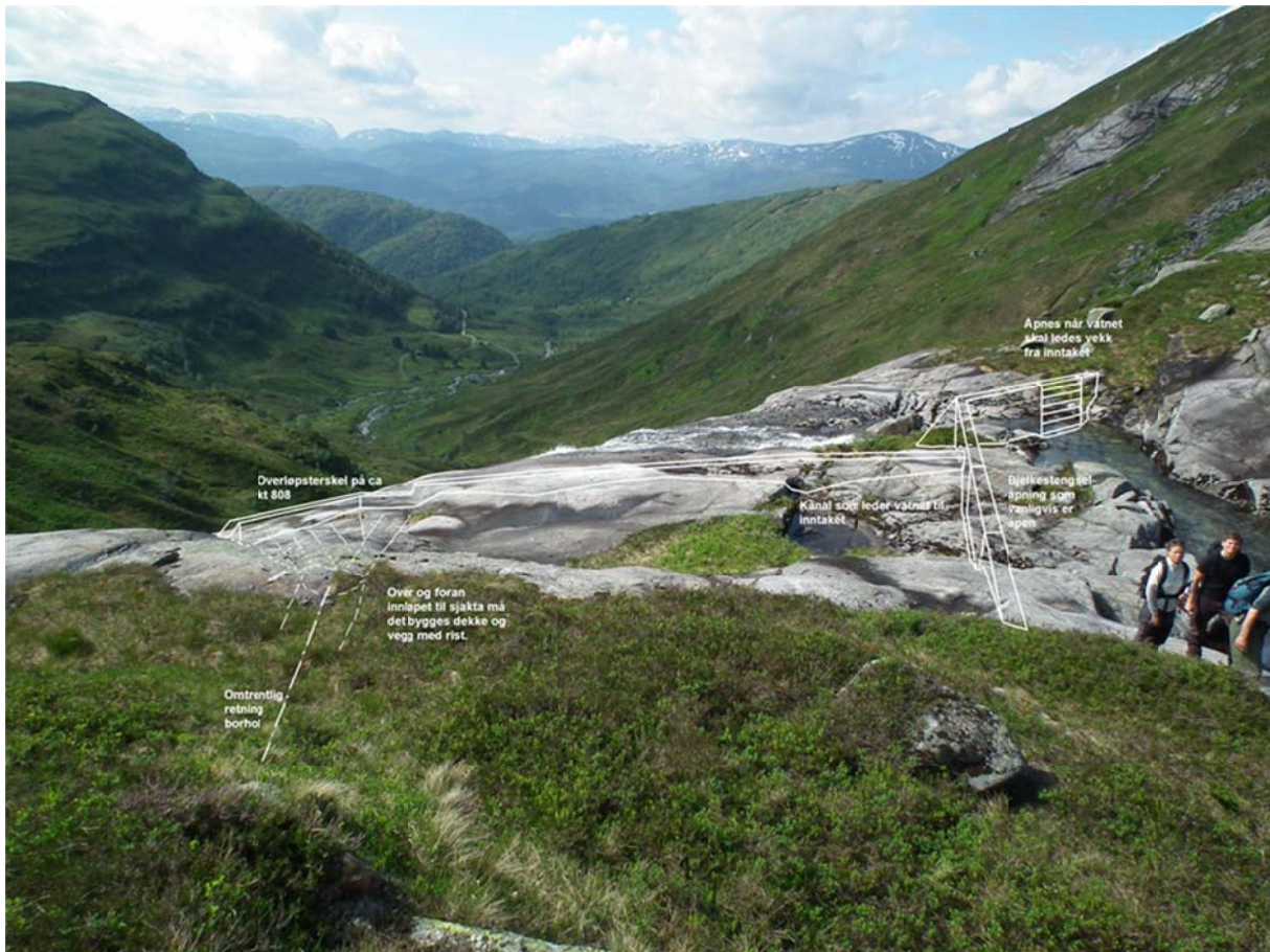
Figur 4: Foto av bekkeinntaket Mustdalen vest, med påteikna inntakskonstruksjonar.
