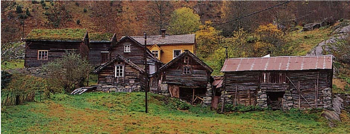
Det vedtaksfreda gårdstunet (Askeladden id 87174) på Kvilekvål. Kilde: Kulturhistorisk vegbok.
