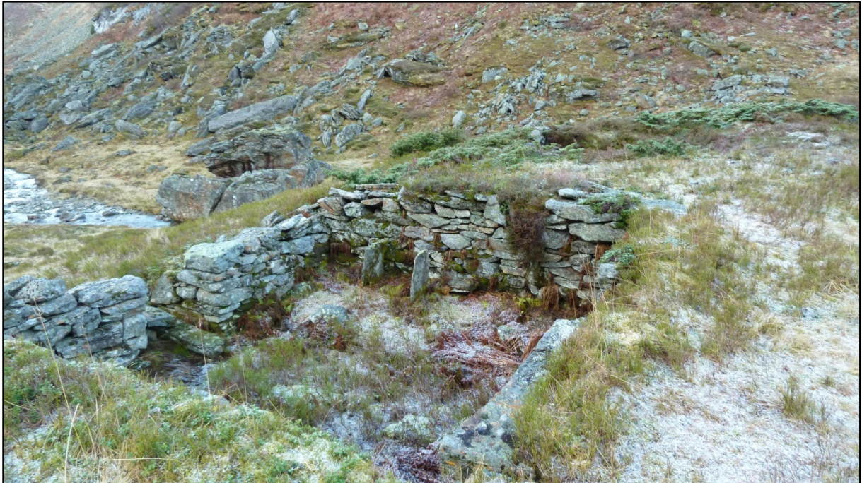
Nyere tids ruin etter stølshus der det har vært fjøs i kjelleren med sel ovenpå. Den øverste av de tre kullgropene / kokegropene er registrert i tilknytning til denne stølsvollen.
