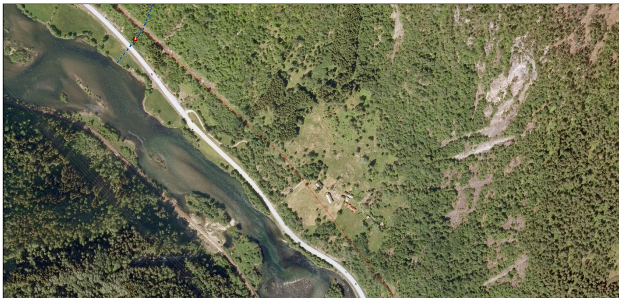
Figur 15. Gården Kvilekvål ligger ca. 500 m øst for planlagt tunnelpåhugg til Skorve kraftverk
