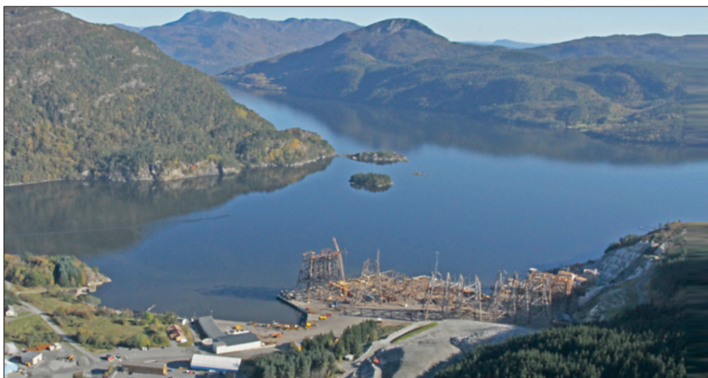
Bilde 5.3 AF Decom ved Raunes / Vatsfjorden. Foto: Norconsult.
