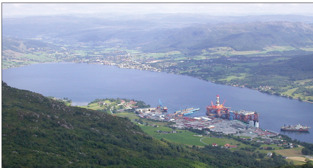
Bilde 5.2 Westcon (venstre) og Ølen betong (høyre) i Ølensvåg. Foto: Norconsult.
