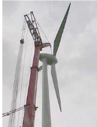
Figur 13: Eksempel på vindturbinfundament og montering av turbin ved hjelp av spesialkran
