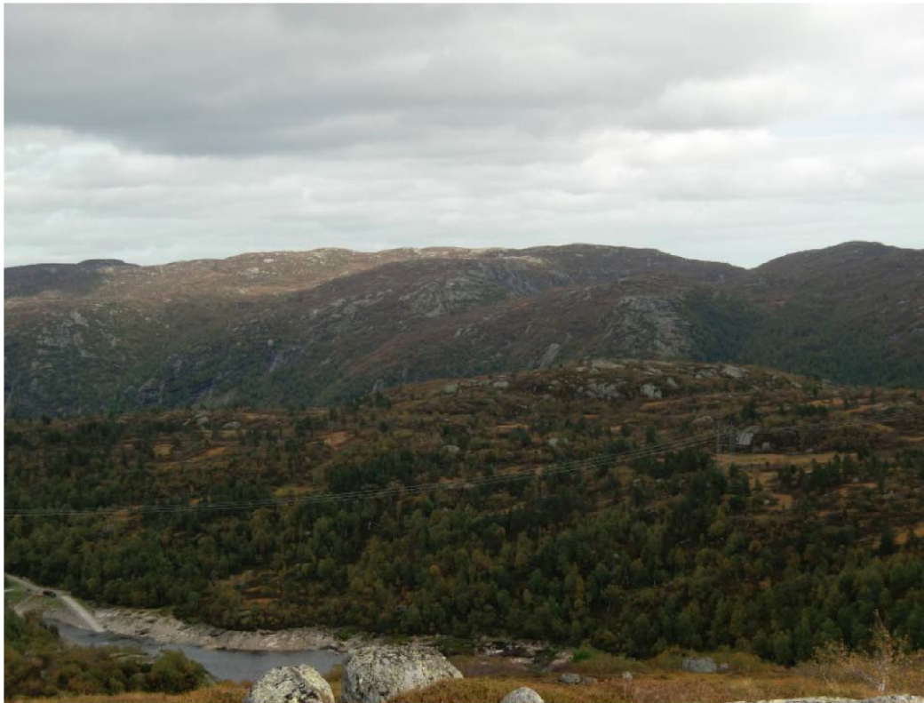
Figur 11: Oversikt over nordre del av Brelandsheia. Anleggsvei fra Breland samt Åstølvatnet sees nede til venstre.
