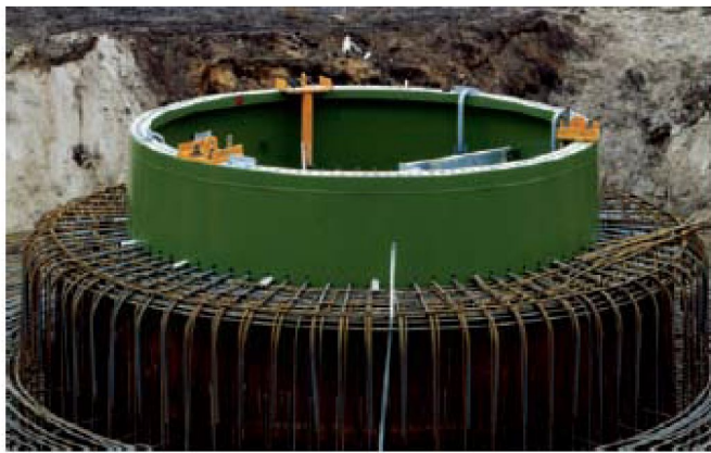
Figur 13: Eksempel på vindturbinfundament og montering av turbin ved hjelp av spesialkran
