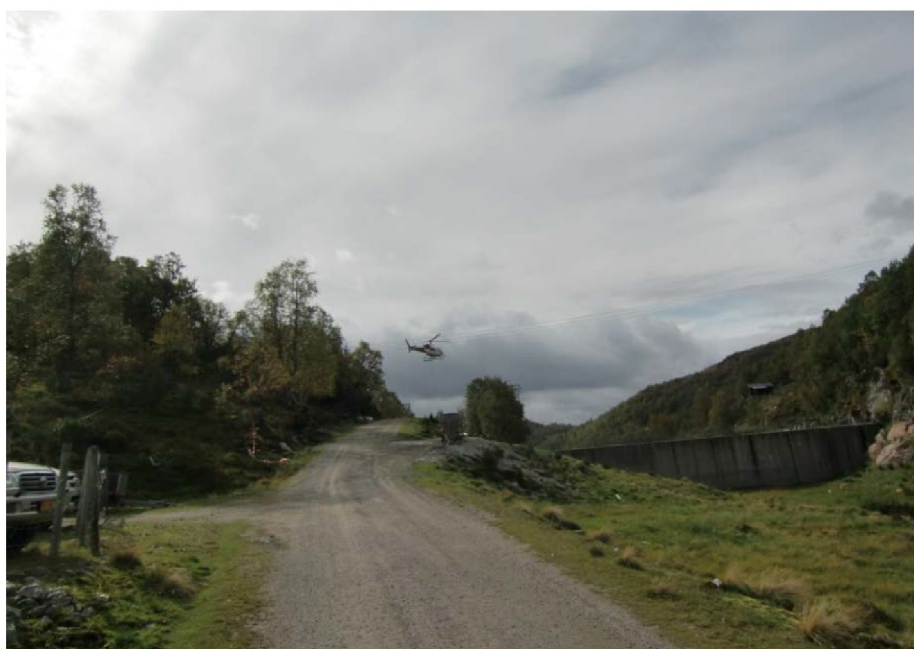
Figur 8: Eksisterende anleggsvei opp til nordenden av Åstølvatnet, samt damanlegg.
