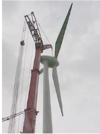
Figur 8: Eksempel på montering av turbin ved hjelp av spesialkran
