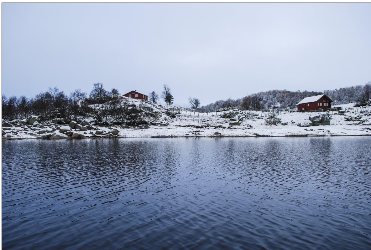
Figur 27: Turbiner på Stuttjørnheii sett fra Svartevann ved Solbu. (3- 4 vingesveip er synlige over åskammen i høyre del av bildet.)
