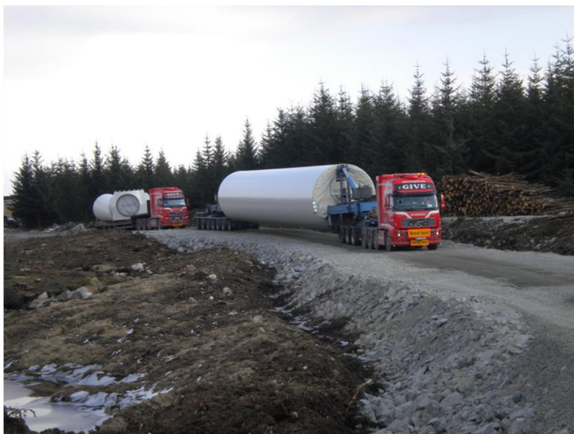
Figur 13: Transport av vindturbindeler
