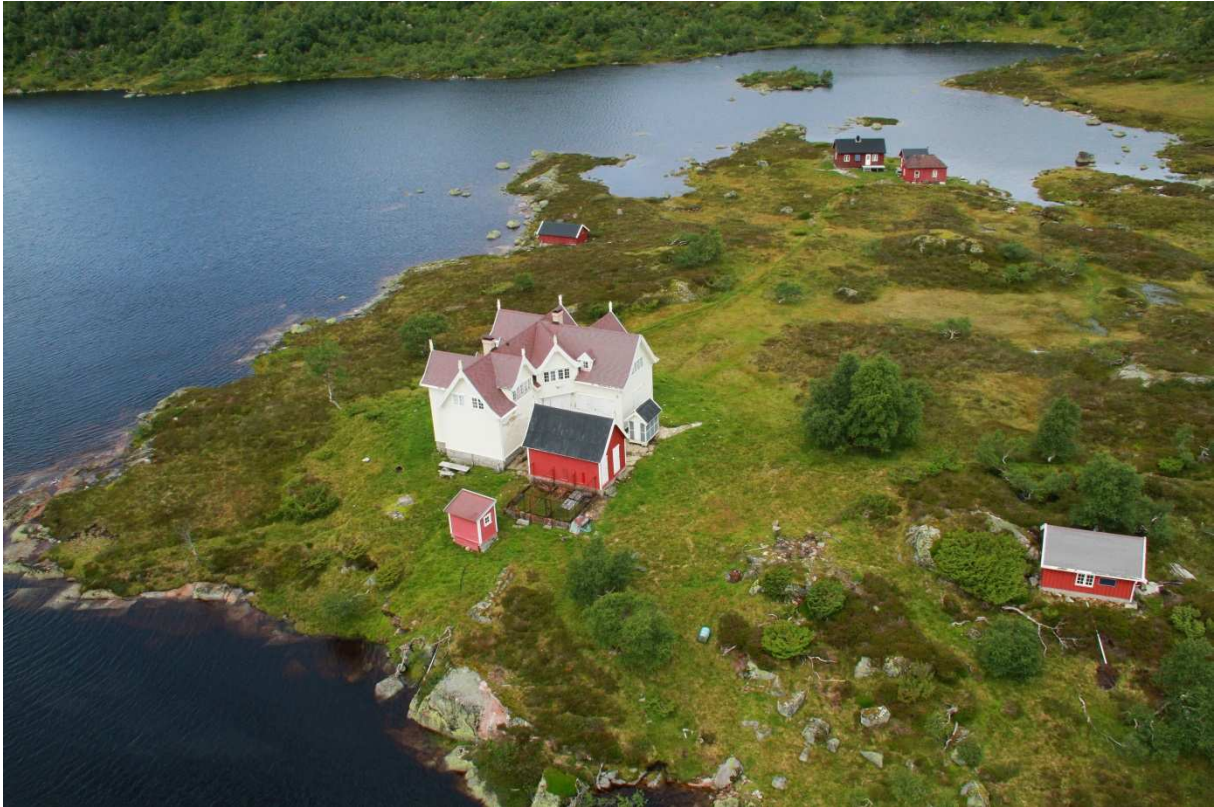
Figur 4-36 Lordehytta med omkringliggende bygninger. Foto: Åseral kommune
