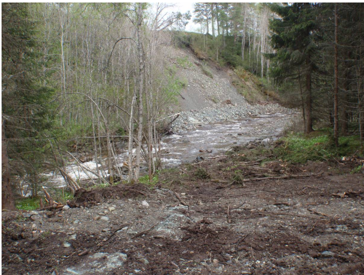
Erosjonsområde (kote 185) oppstrøms bro over Mosbryndskjerva
