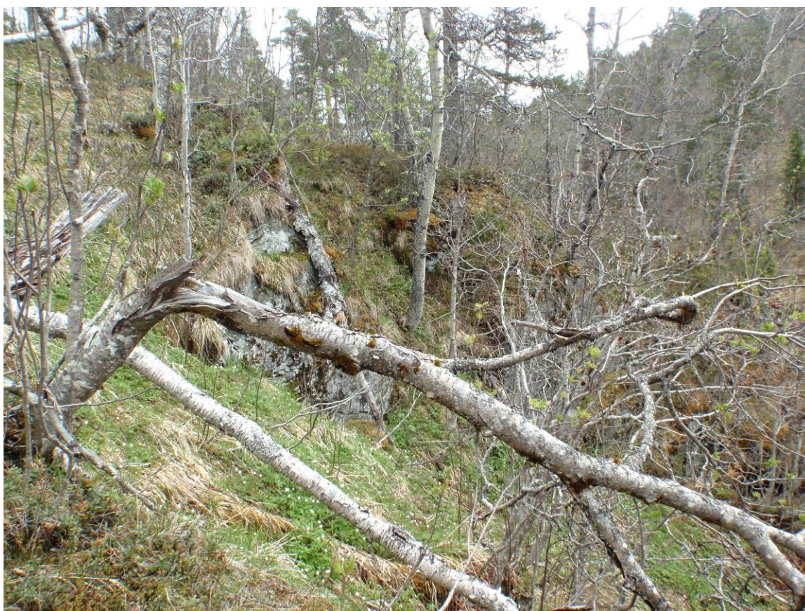
Første del av vannvei like nedstrøms inntak. Utfordrende parti.
