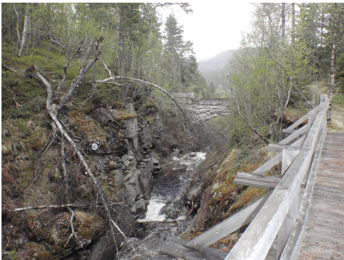
Rester etter tidligere kraftverk
