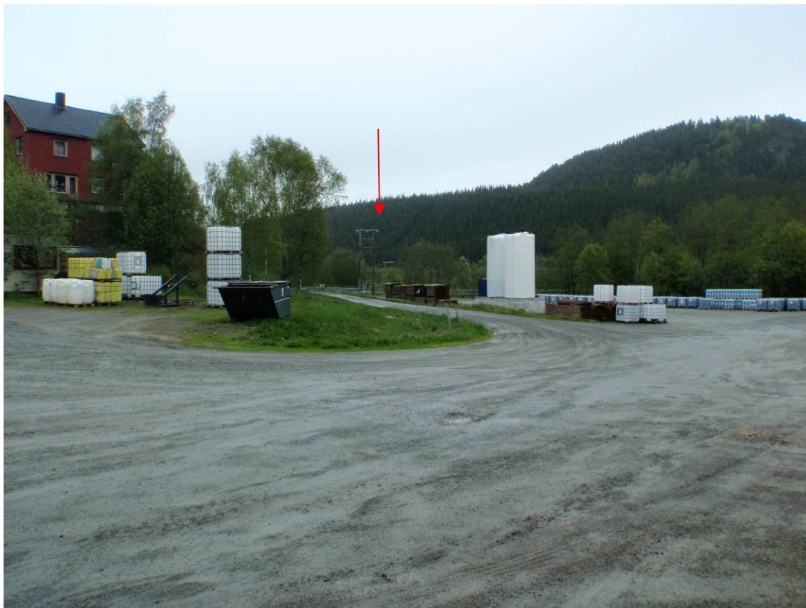
Trafo – planlagt nettilknytning
