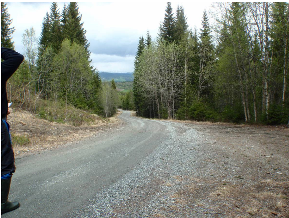
Vannvei langs eksisterende bomvei
