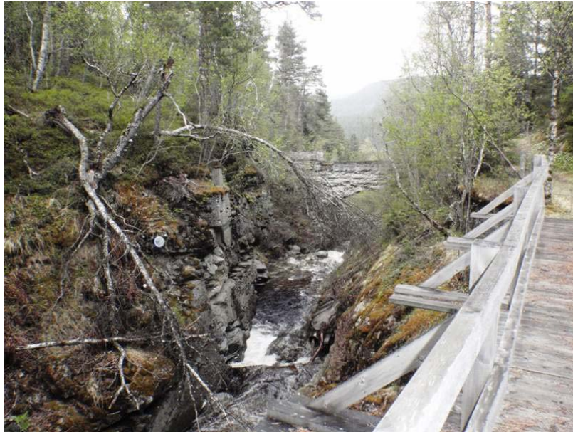
Figur 3.8 Bru ca. 200 m oppstrøms Skjerva mølle. En av de to gamle kraftverksdammene kan ses i bakgrunnen.
