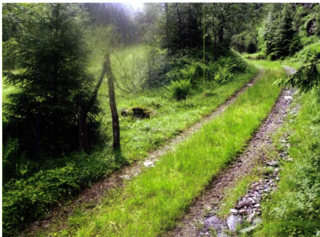
Bilde 4: Nedre del av Langedalen på vestsiden av Langedalselvi. Eksisterende vei fra fjorden og opp til kraftstasjonsområdet opprustes etter behov og benyttes som atkomst i anleggsfase og driftsfase.
