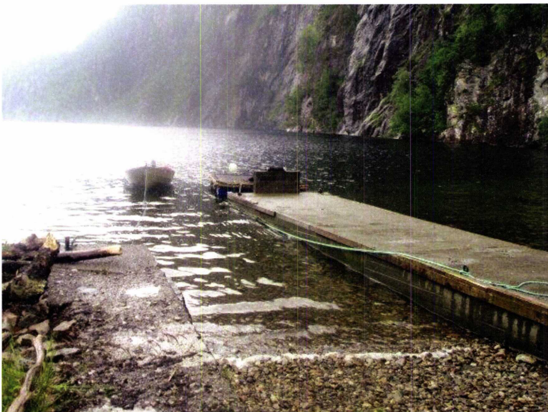
Bilde 2: Landingsplass for båt ved utløpet av Langedalselvi. Anleggsmaskiner og materiell vil i hovedsak fraktes til Langedalen og Fjellstølen med båt. Bildet er tatt mot nordøst.
