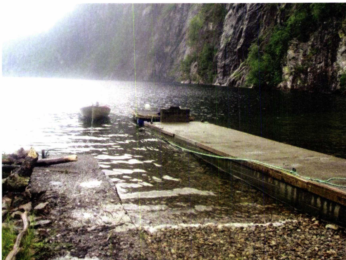
Bilde 2: Landingsplass for båt ved utløpet av Langedalselvi. Anleggsmaskiner og materiell vil i hovedsak fraktes til Langedalen og Fjellstølen med båt. Bildet er tatt mot nordøst. (Foto: Sweco Norge AS)
