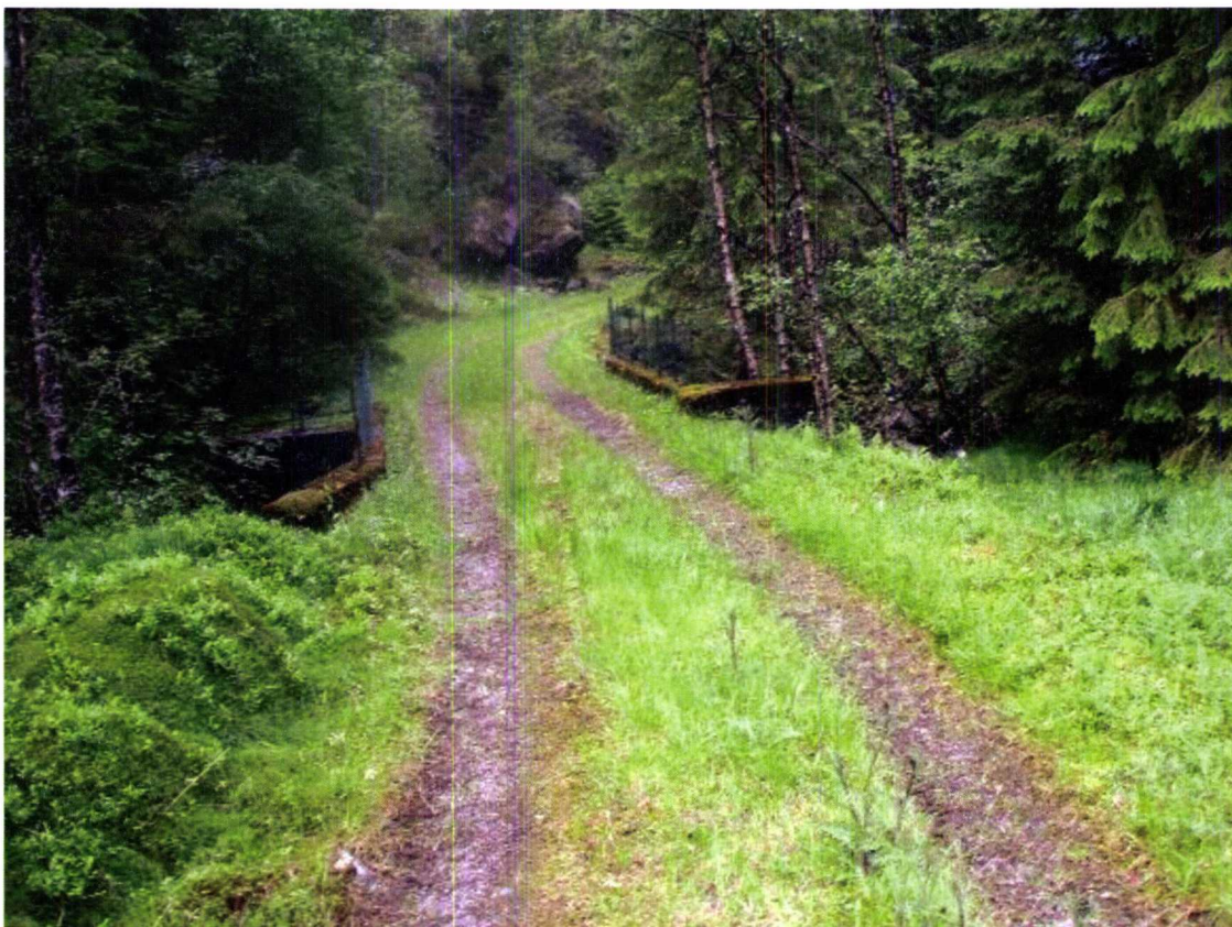
Bilde 6: Bro over Langedalselvi på ca kote 60 moh. (Foto: Sweco Norge AS)
