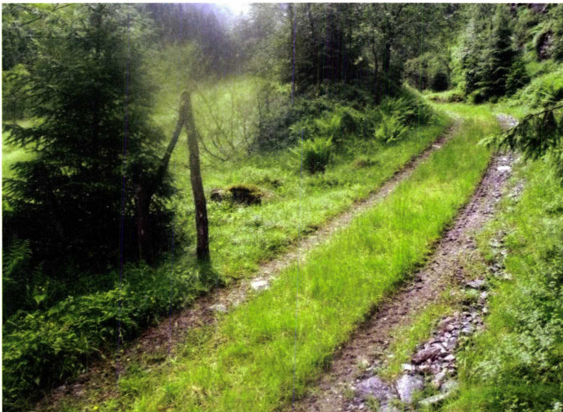
Bilde 4: Nedre del av Langedalen på vestsiden av Langedalselvi. Eksisterende vei fra fjorden og opp til inntaksområdet opprustes etter behov og benyttes som atkomst i anleggsfase og driftsfase. (Foto: Sweco Norge AS)
