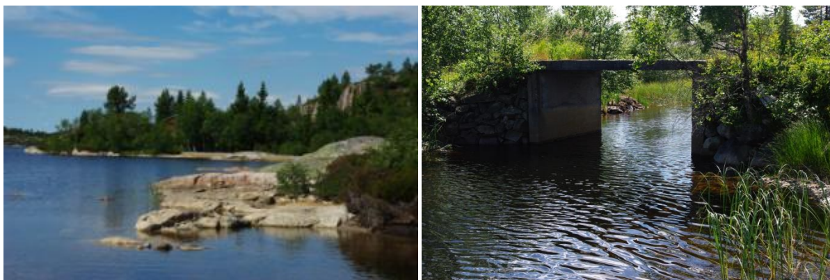
Figur 1. Til venstre det tidlegare utløpet til Holmvatn, som er sperra med 3 mindre betongdammar. Eventuelt overvatn blir slept gjennom Stokkosen, slik at tilsiget til Holmvasselva er sterkt redusert. Til høgre kanalen mellom Holmvatn og Breilivatn. Foto Helge Kiland 24.7.2013.
