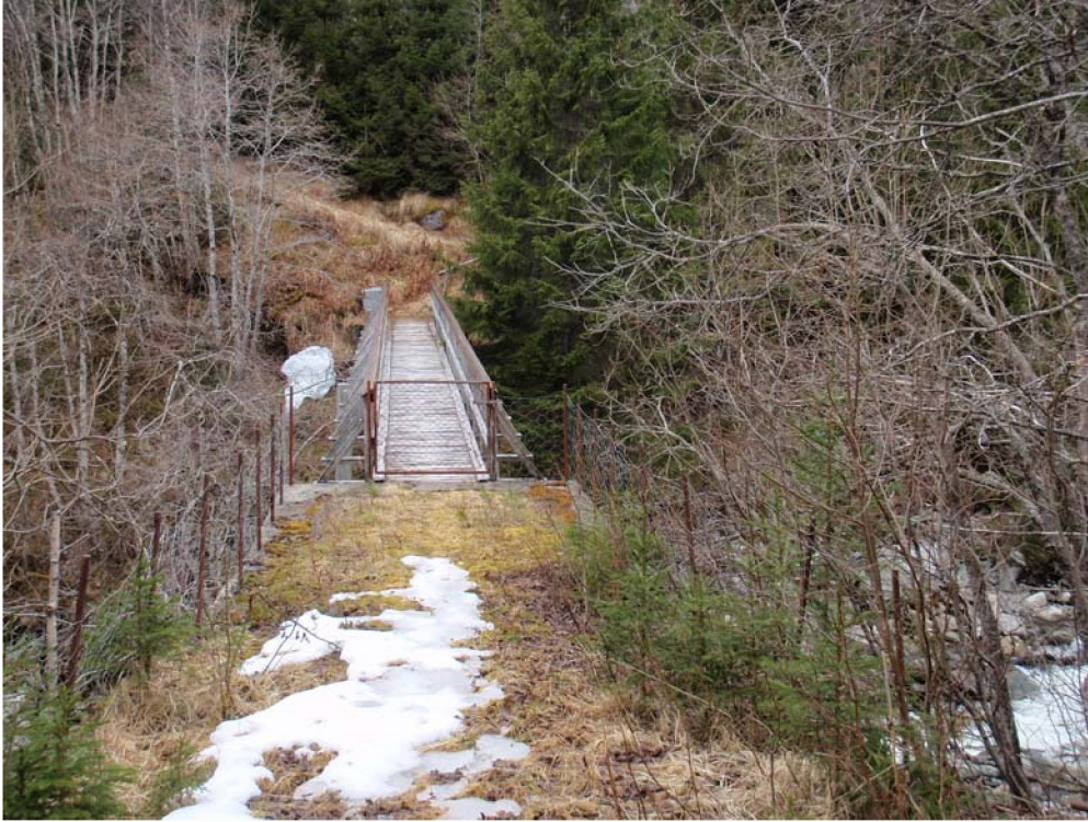
Bru over elv like nedenfor inntaket
