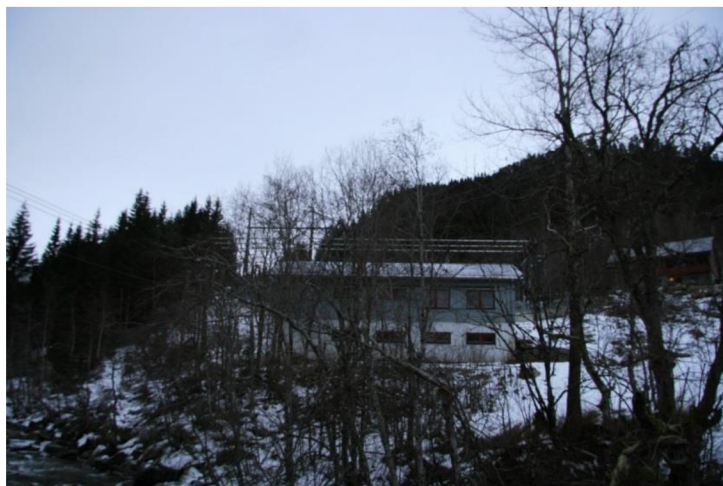
Figur 1 Eksisterende Trafostasjon ca. 313 moh
