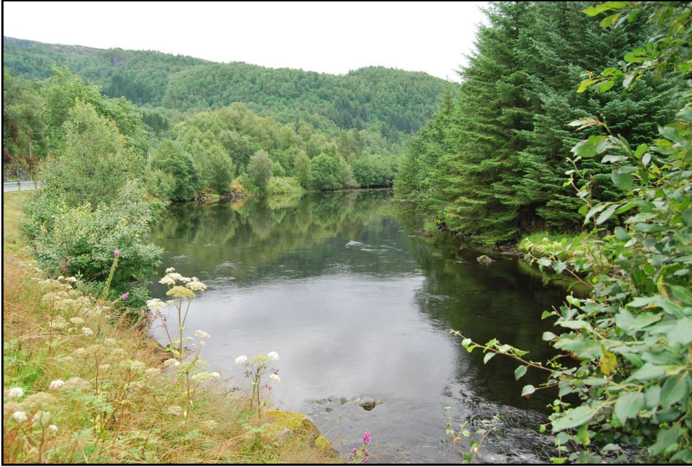
2. Inntaksområdet, fotograf står i inntakskanal. Terskel vert bygt til høgre i bildet.
