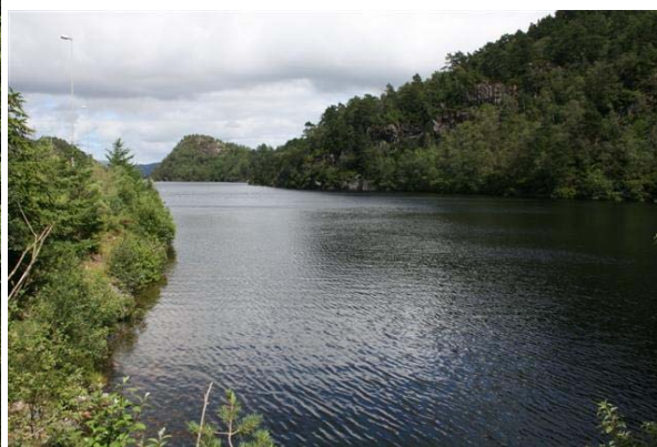
Vestre bredd med fyllingsfot og inngrep/veg
