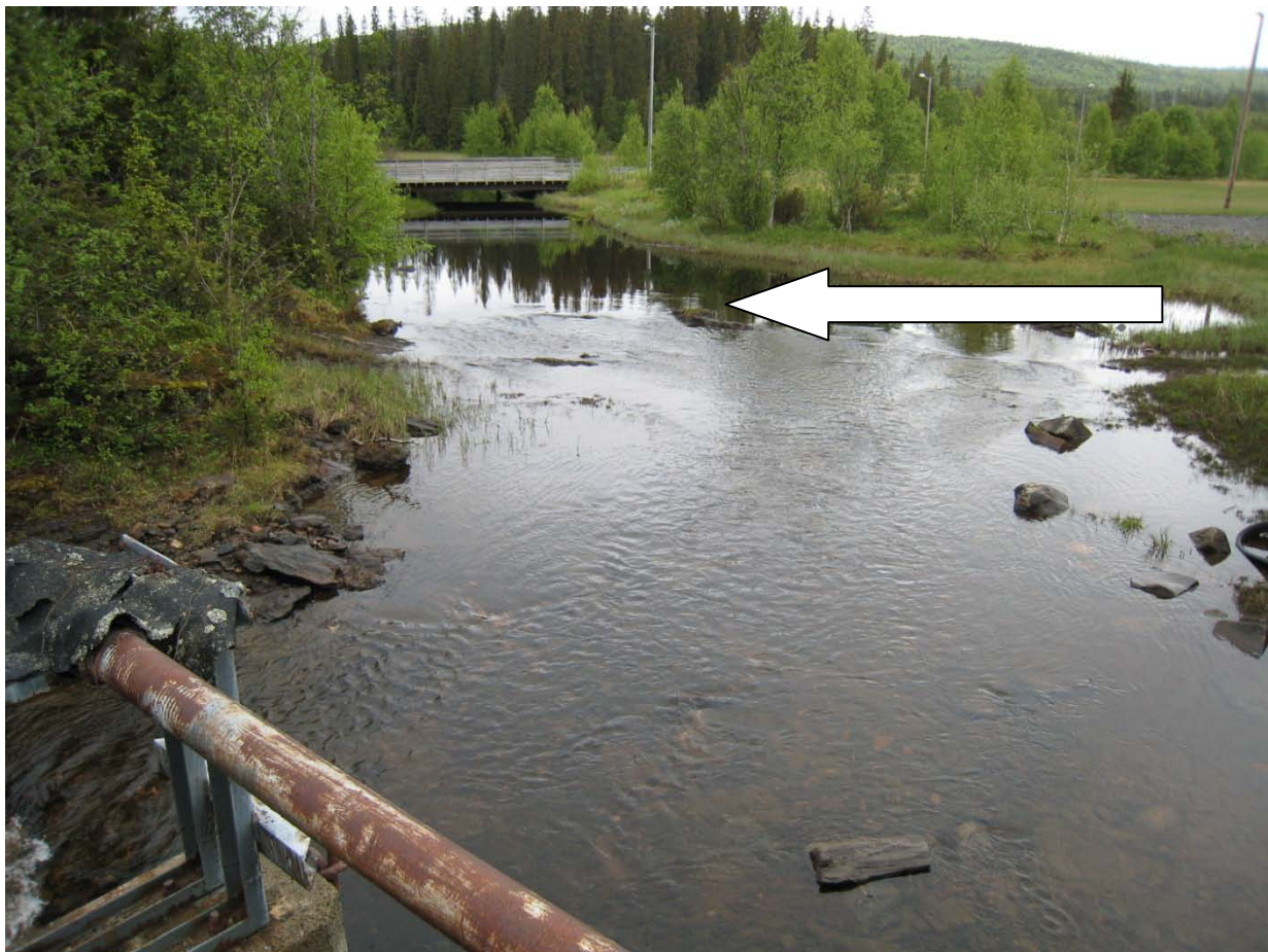
Bilde 4.1: Elvestrekningen mellom dammen og den naturlige terskelen i elveløpet. Naturlig terskel er angitt med hvit pil.
