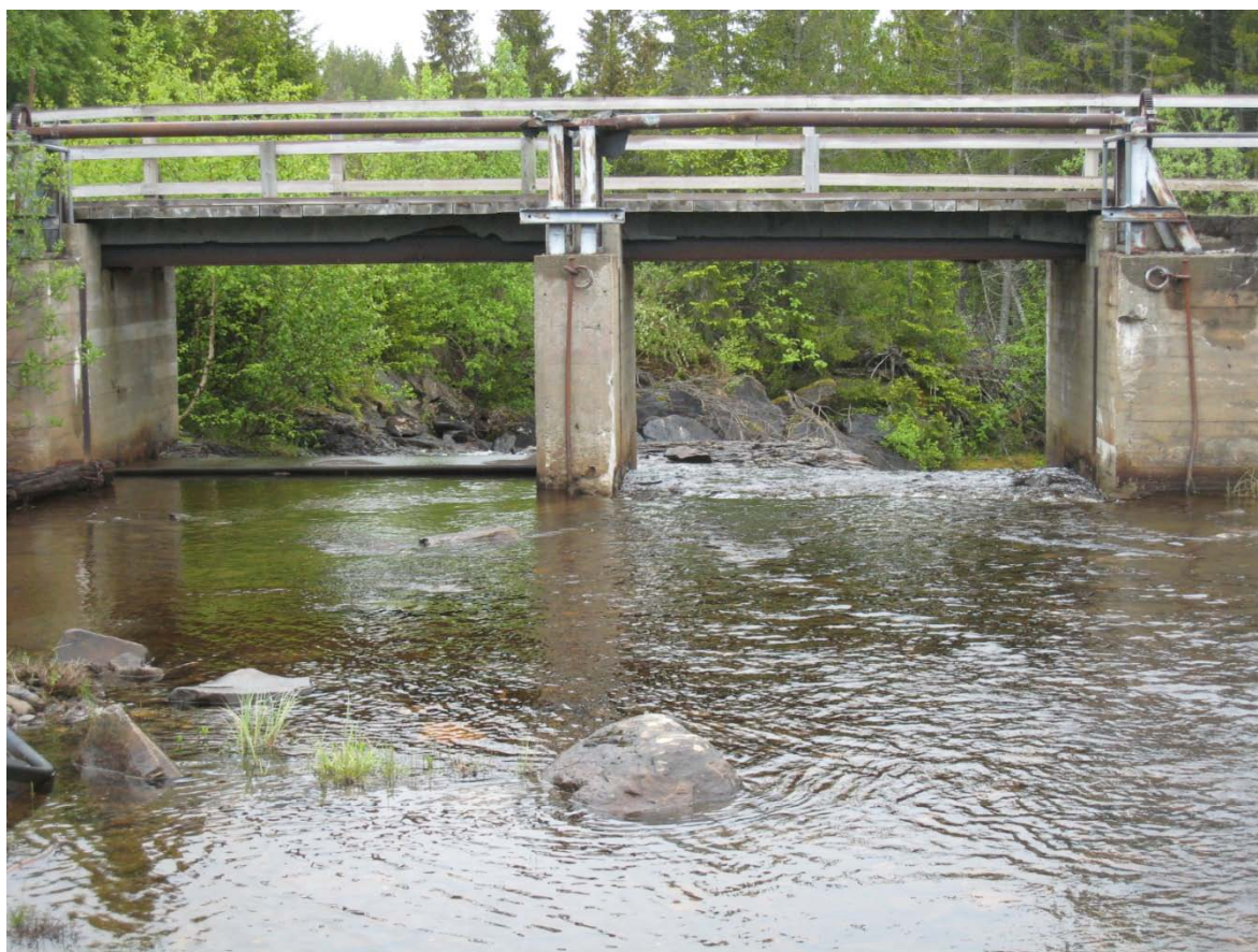
Bilde 1.1: Dammen sett oppstrøms. Luka til høyre er fjernet.
