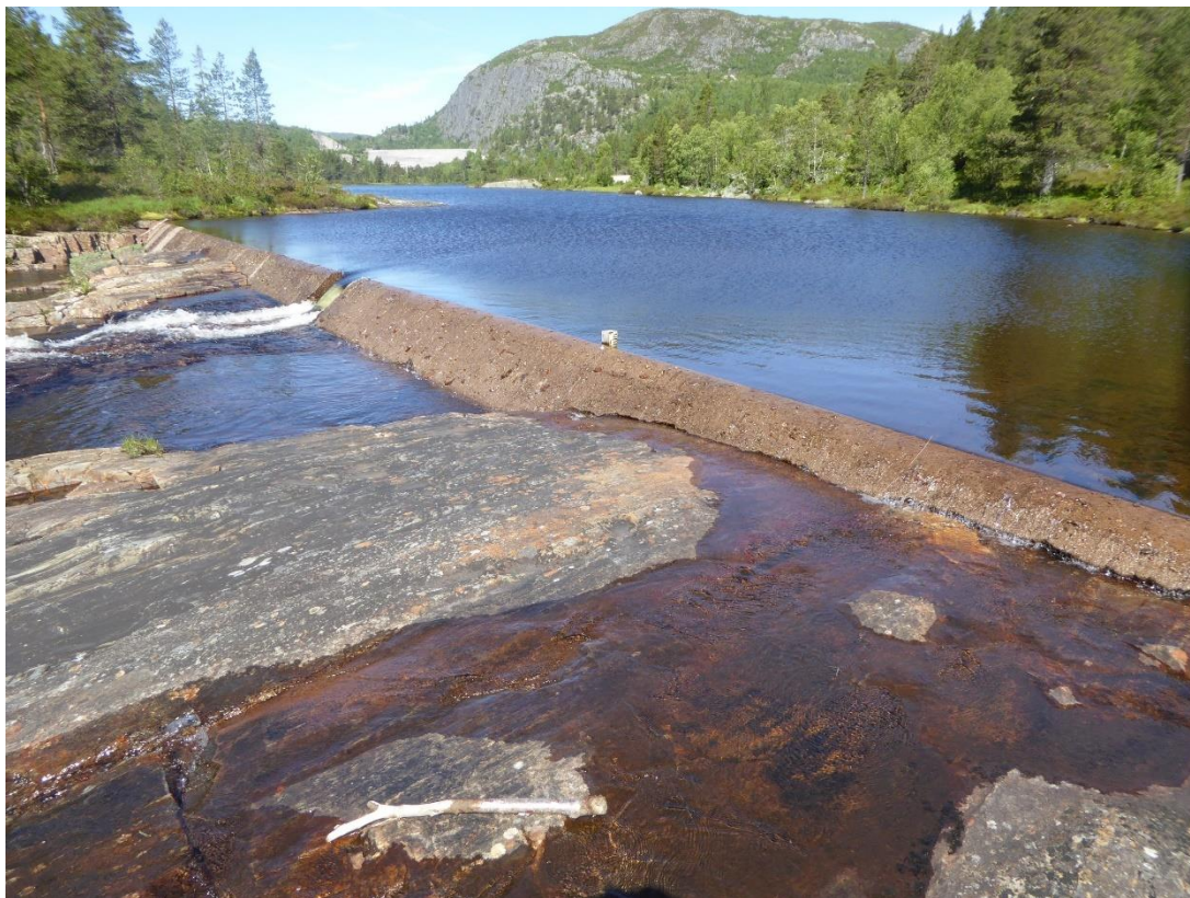
Fig 4.11 Foto av terskel ved utløpet av Streitsvatn.
