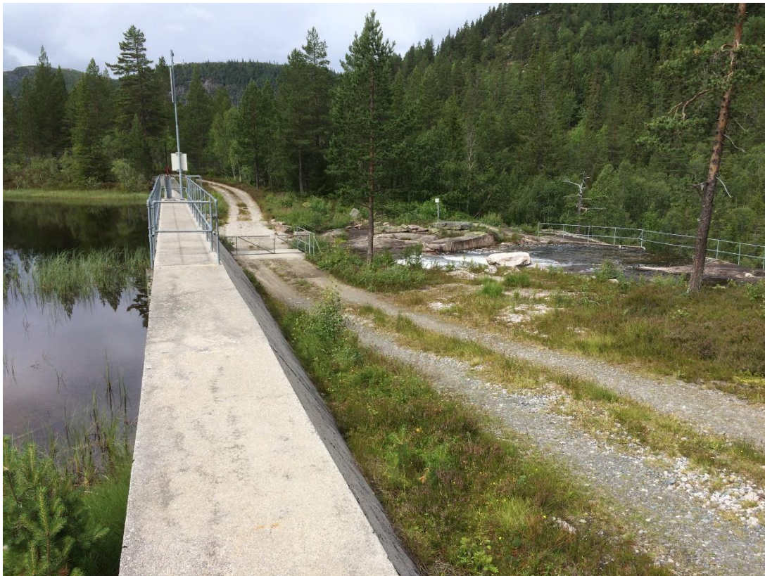
Fig 4.15 Slipp av MVF fra Ulvsvatn
