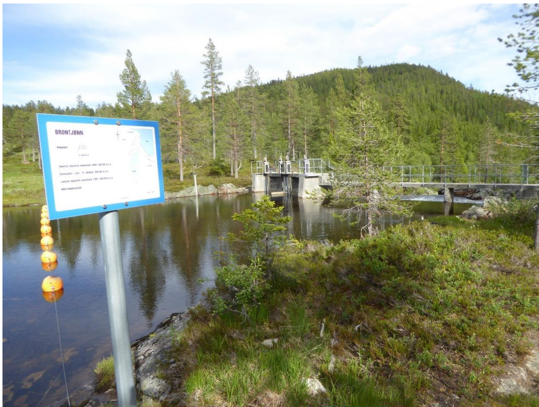
Fig 4.13 Foto av slippunkt ved utløpet av Brontjønn.
