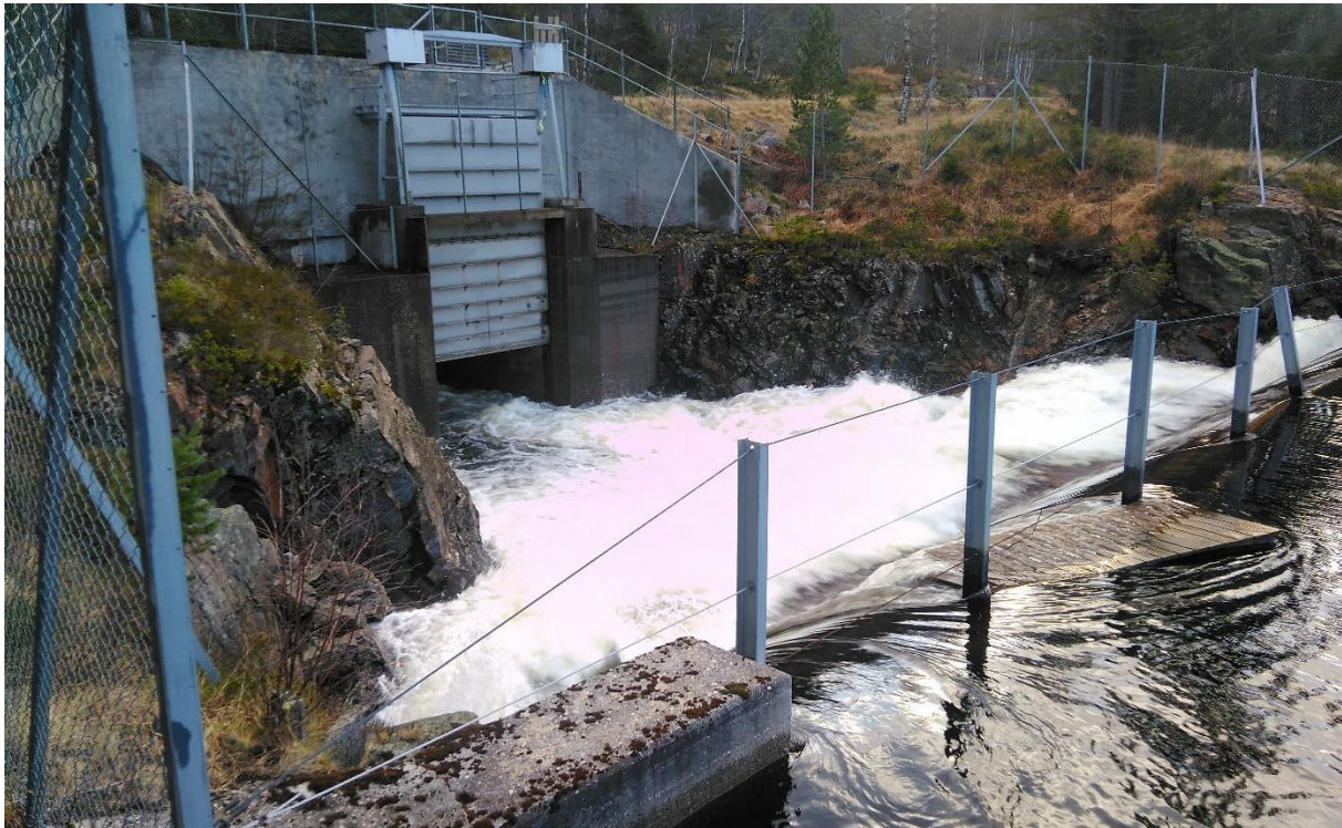
Bilde 14: Tunellinntak i Ulvsvatn 31. oktober 2017.
