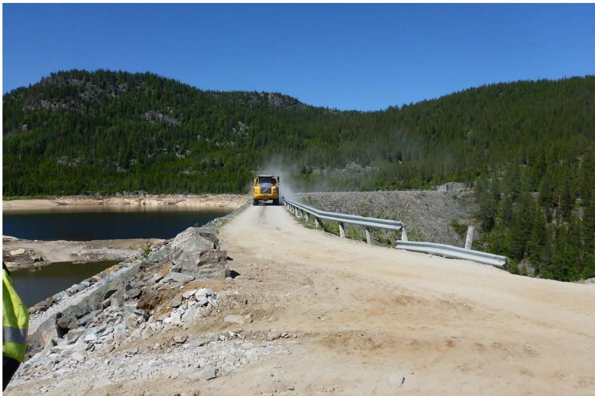
Bilde 11. På Votna dam pågikk det anleggsarbeid sommeren 2017.
