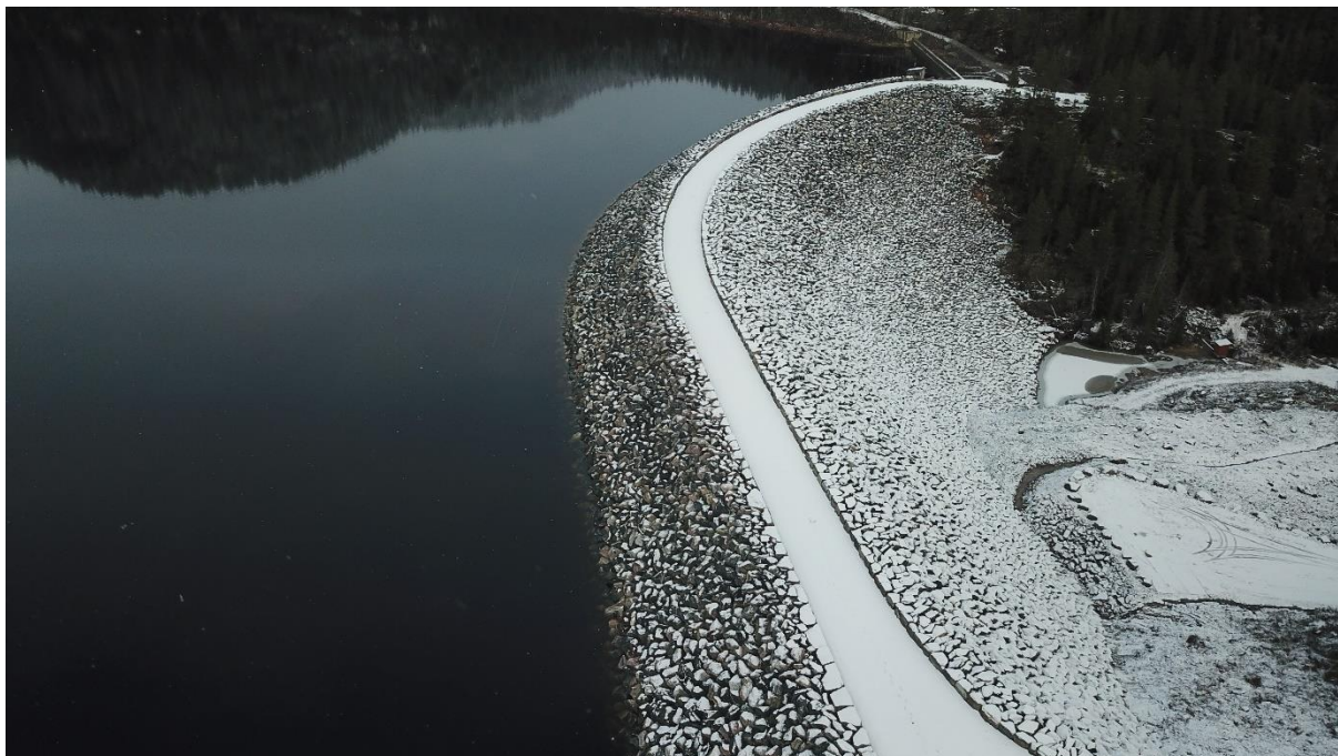
Bilde 12. Votna dam ferdig plastret, fotografert fra RPAS 10. november.
