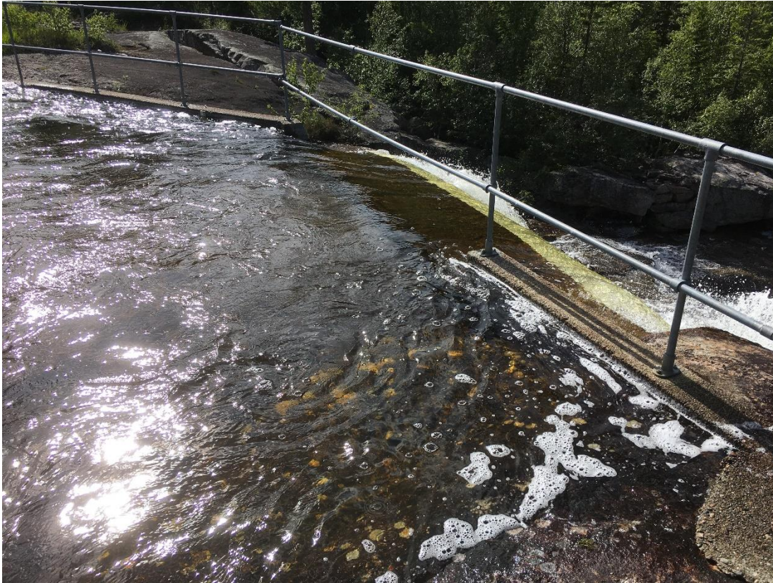
Figur 14 Fotopunkt 5 Ulsvatn- slippsted for minstevannføring til Bondøla. Slipp av ca 2000 liter per sekund
