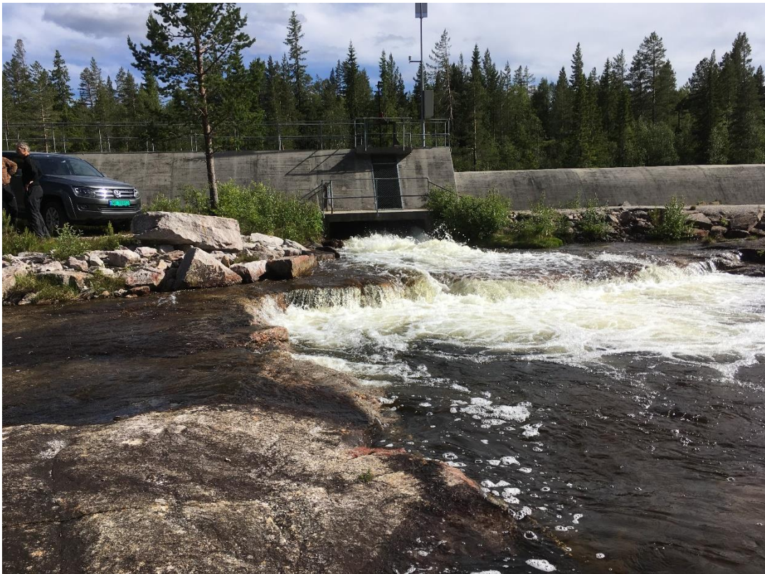
Figur 15 Fotopunkt 5 Ulsvatn- slippsted for minstevannføring til Bondøla. Vannføring er ca 2000 liter per sekund
