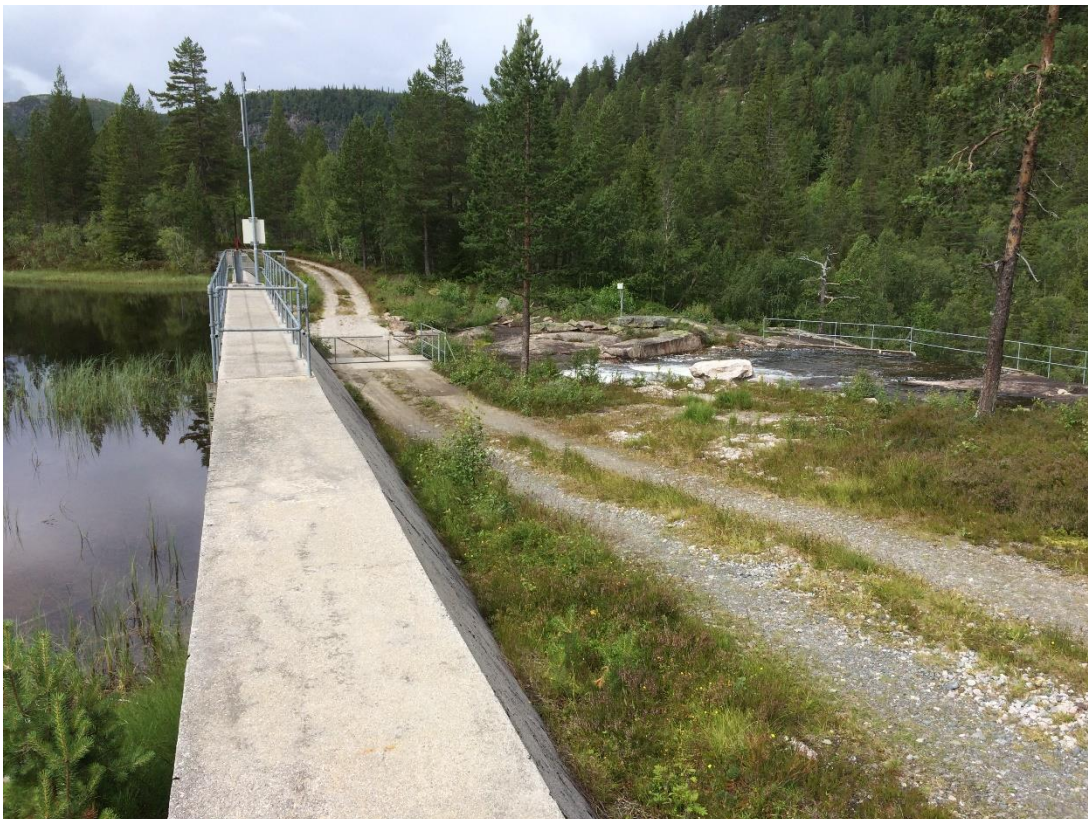
Figur 13 Fotopunkt 5 Ulvsvatn- slippsted for minstevannføring til Bondøla
