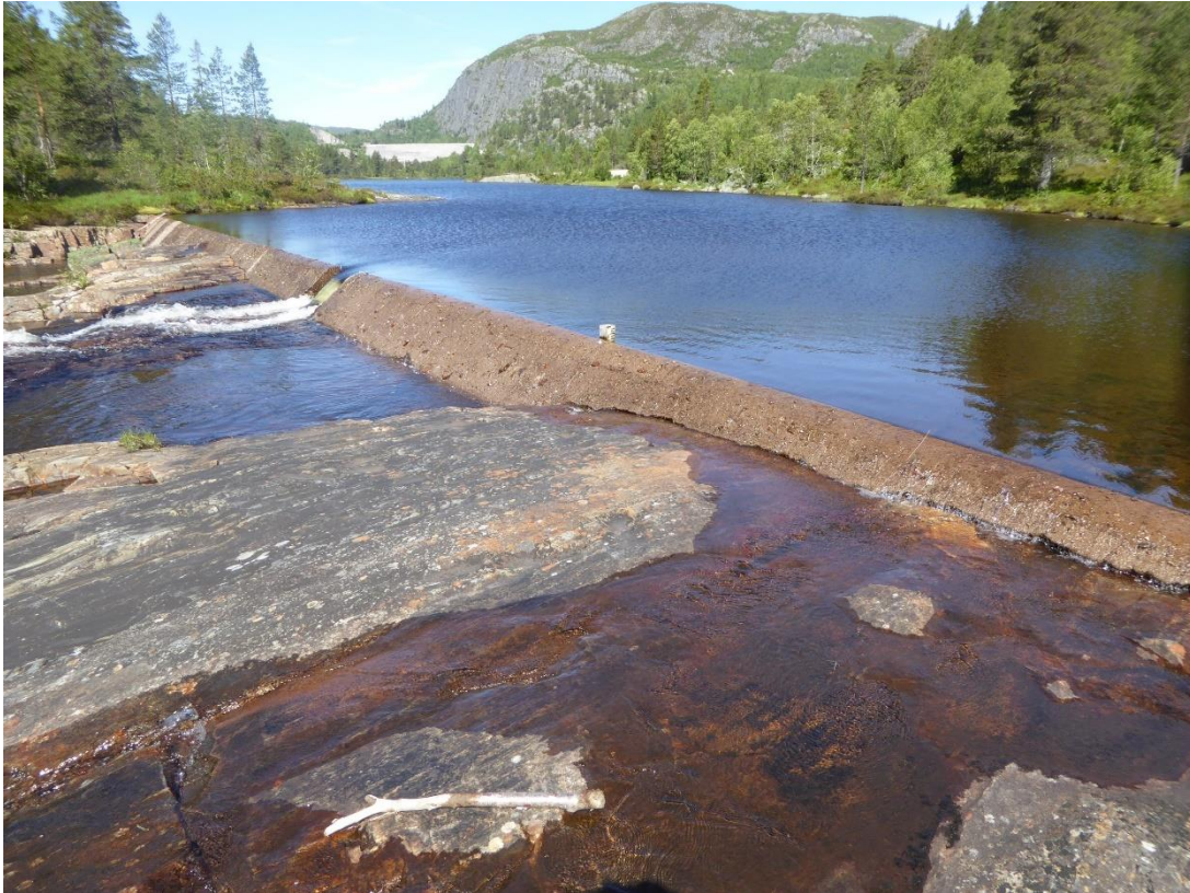
Figur 24 Fotopunkt 9 Streitsvatn. Målested for minstevannføring fra Torsdalmagasinet. Dam Torsdal i bakgrunn
