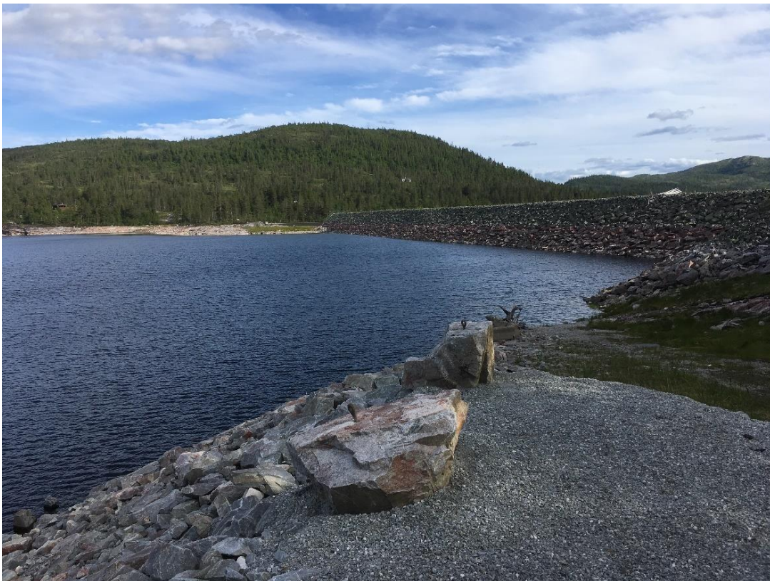
Figur 31 Fotopunkt 13 Dam Øysæ. Vannstand er 678,5 moh
