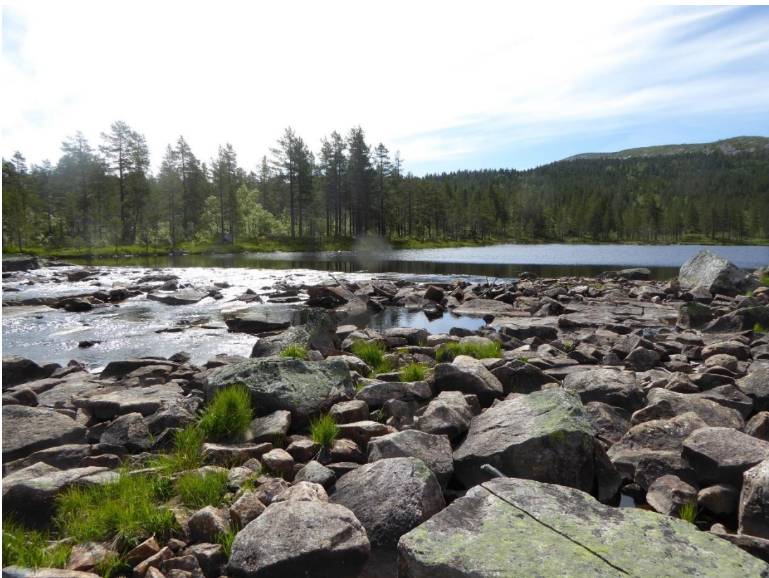
Figur 23 Fotopunkt 8. Terskel like oppstrøms Haukrei kraftverk. Vannføring ca 500 liter per sekund
