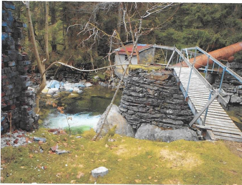
Objekt 4a: Gangbru, rørgate og deler av kraftstasjon.
