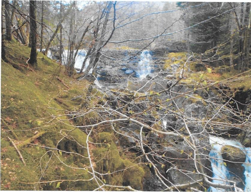
Objekt 6a: Dam.
