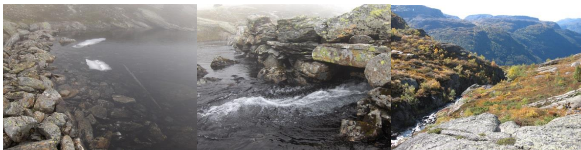
Ved Kvernavatnet, gammel dam. Utsikt fra øvre del av terrenget.
