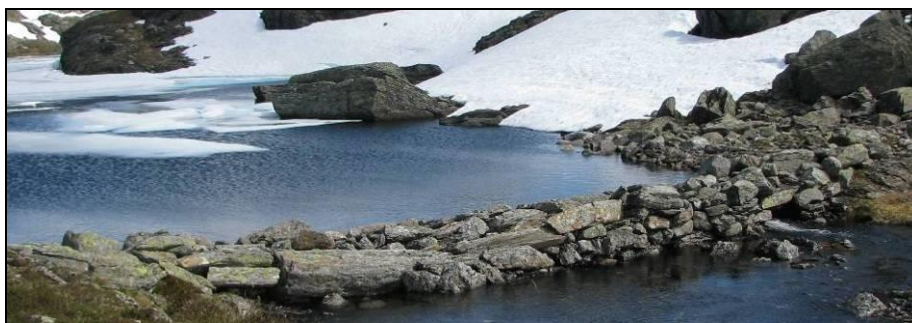
Figur 4: Eksisterende steindam med åpen luke
