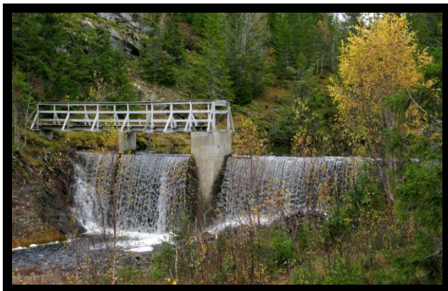
Skordalsdammen med overløp 16/10-08.
