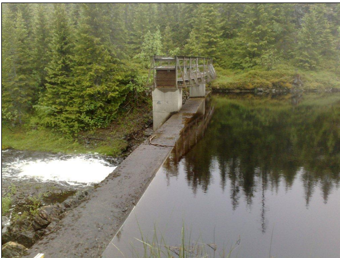
Figur 6. Demningen ved Skordalstjønna sett fra sørsiden
