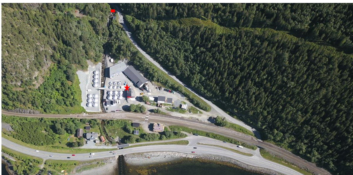
Figur 3. Dronefoto av settefiskanlegget slik det er i dag. Inntaket ved fossen ses til høyre i bildet, og er markert med firkant. Inntaket på mikrokraftverket er markert med stjerne. Foto: Marco Schaer
