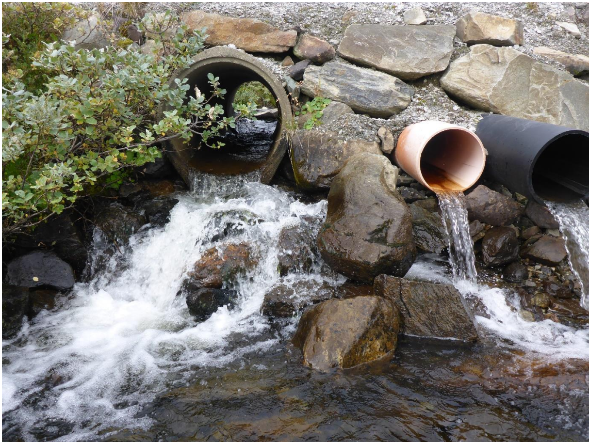
Bilde 6. Bekk i vest til Varaldsetvatnet. Middels stor bekk som går under veien i rør. Fisk passerer på optimal vannføring.
