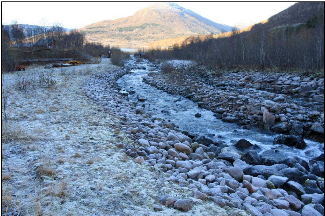
Figur 8. Omfattende elveforebygging i nedre del av Breidvikelva. Bildet er tatt ved skytebanen nedover mot Riksvei 17 og utløpet i Nordfjorden. Foto: Ingve Birkeland.
