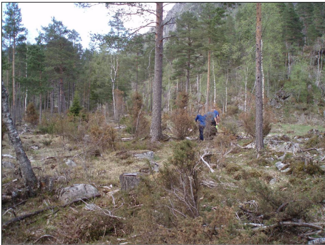
Ved pel 150, oppover langs rørgaten
