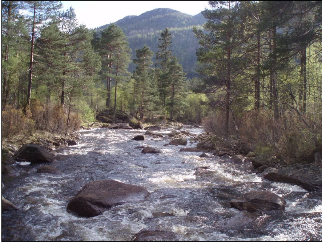
Elven like nedstrøms utløp fra kraftstasjon
