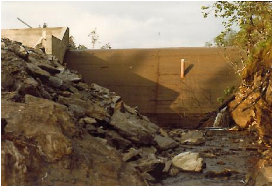
Bilde 9 Nedstrøms dammen, 1981
