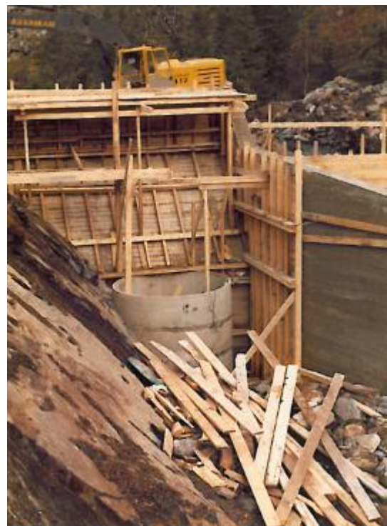
Bilde 6 og 7 Bygging av dam. Oktober 1981
