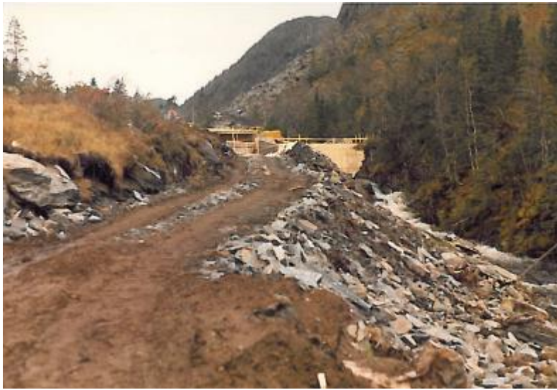
Bilde 8 Bygging av dam. Rokkelva. Oktober 1981
