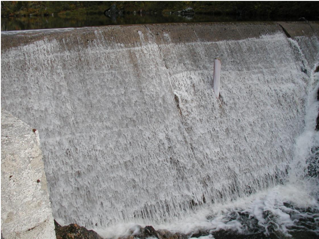
Bilde 3 Nedstrøms dammen
