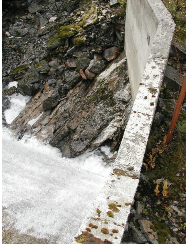
Bilde 2 Betongvegg avgrensner dammen til 18,45 meter bredde.
